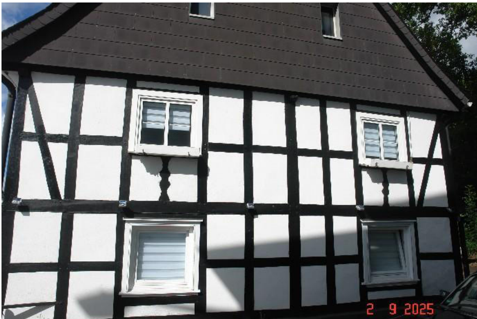
Bild 6: Ansicht des Bewertungsobjekts aus östlicher Richtung
