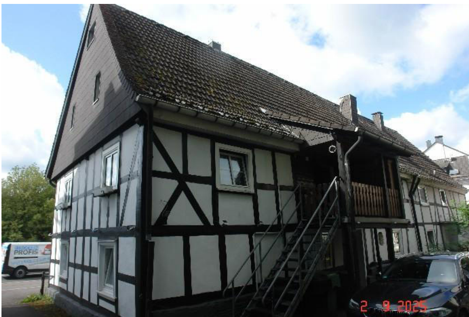
Bild 2: Ansicht des Bewertungsobjekts aus nordöstlicher Richtung
