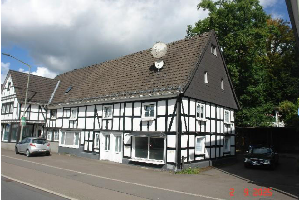
Bild 5: Ansicht des Bewertungsobjekts aus südöstlicher Richtung
