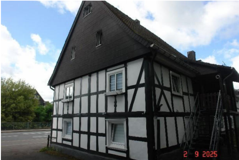
Bild 3: Ansicht des Bewertungsobjekts vom Nachbargrundstück aus
