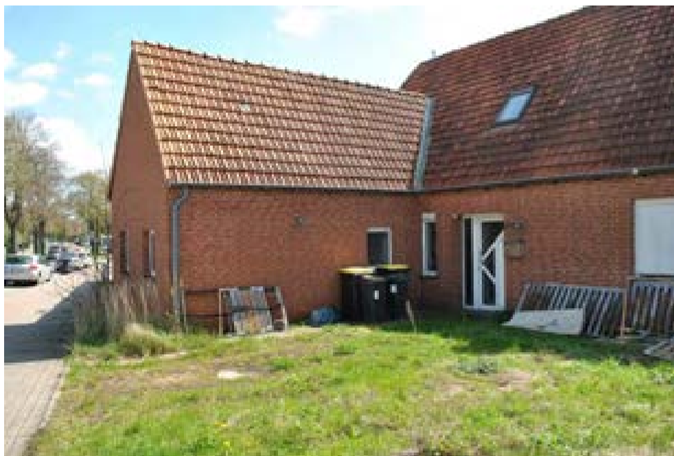
Hofansicht ehemaliges Stallgebäude/ Eingangsbereich
