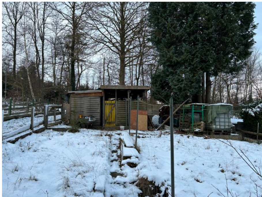
Nordansicht des Holzschuppens
