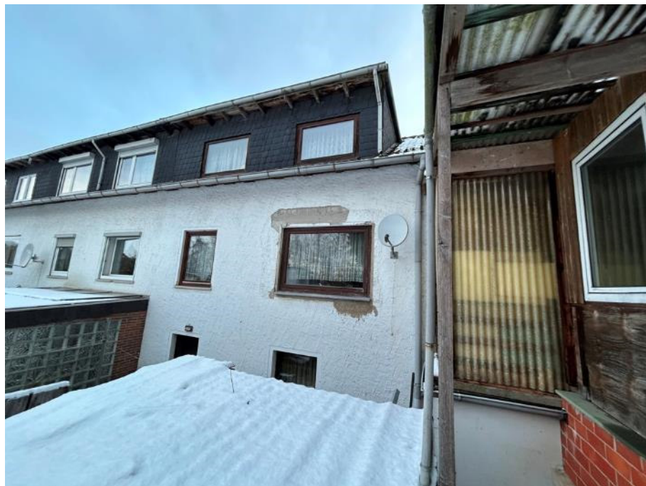
Südansicht (Rückansicht) des Einfamilien-Reihenendhauses mit Anbau
