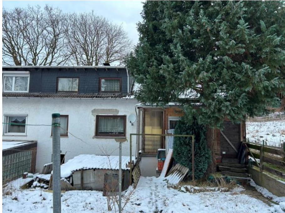
Südansicht (Rückansicht) des Einfamilien-Reihenendhauses mit Anbau
