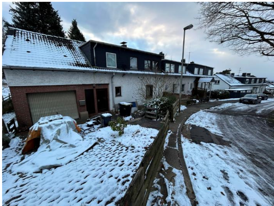
Nordostansicht (Straßenansicht) des Reihenhauses und der Erschließungsstraße
