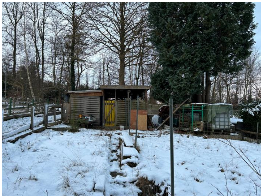
Nordansicht des Holzschuppens
