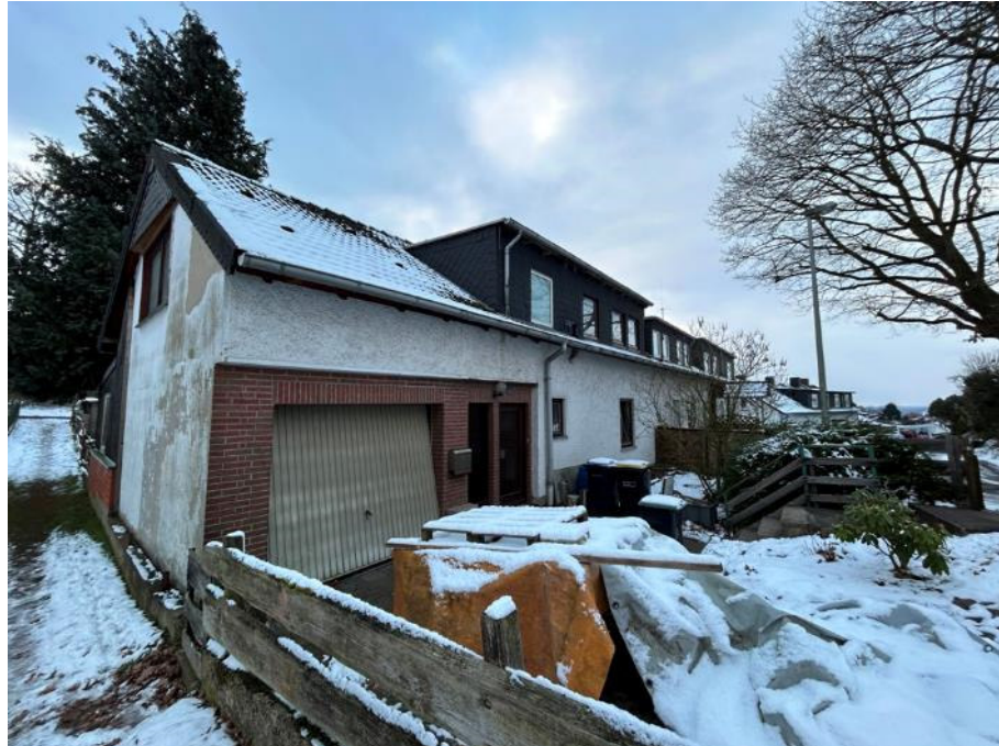
Nordostansicht (Straßenansicht) des Einfamilien-Reihenendhauses mit Garage
