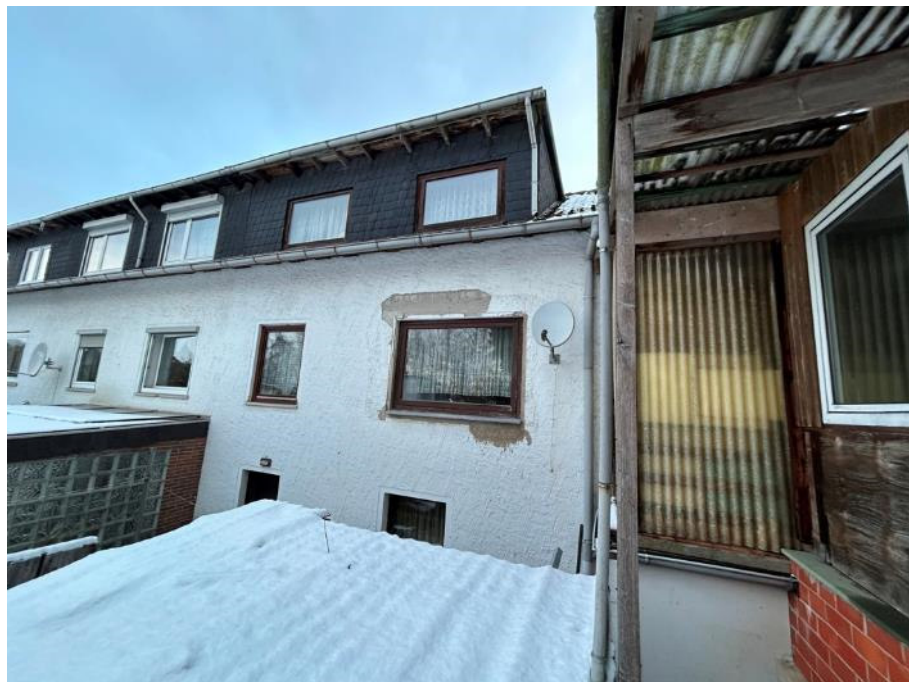
Südansicht (Rückansicht) des Einfamilien-Reihenendhauses mit Anbau
