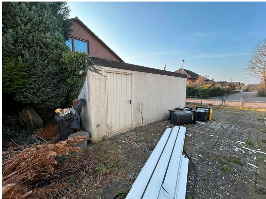
Südostansicht der Garage
