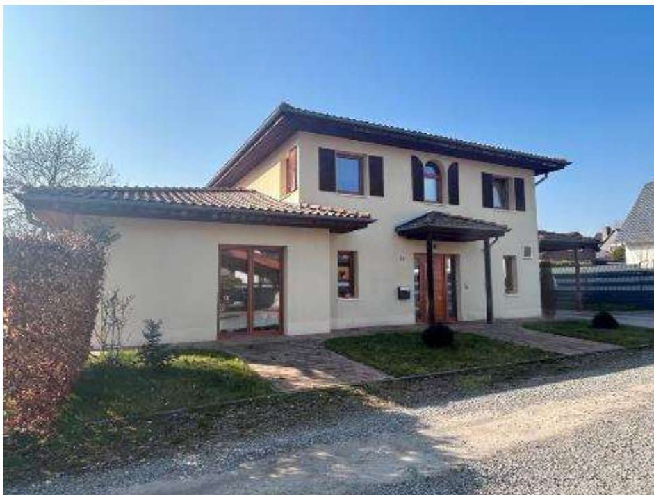
Südostansicht (Straßenansicht) des Einfamilienhauses
