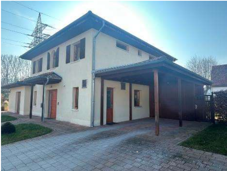
Nordostansicht (Straßenansicht) des Einfamilienhauses mit Carport
