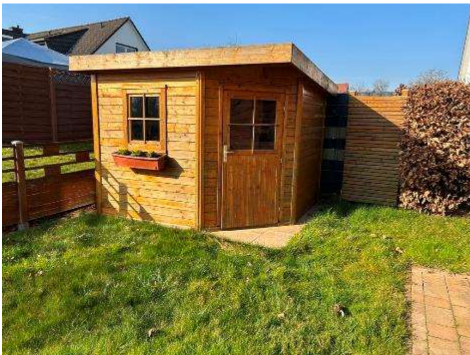
Südostansicht des Gartenhauses
