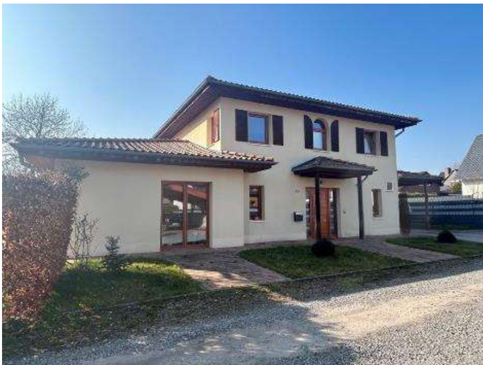
Südostansicht (Straßenansicht) des Einfamilienhauses
