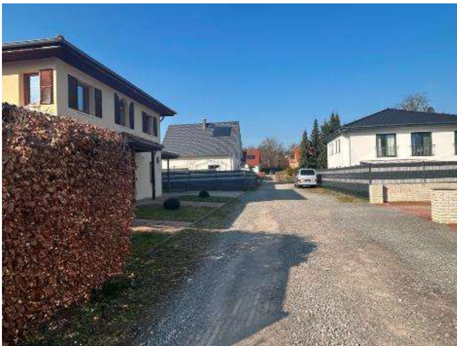
Südansicht des provisorisch ausgebauten Teilstücks des Privatwegs (Flurstück 1241)
