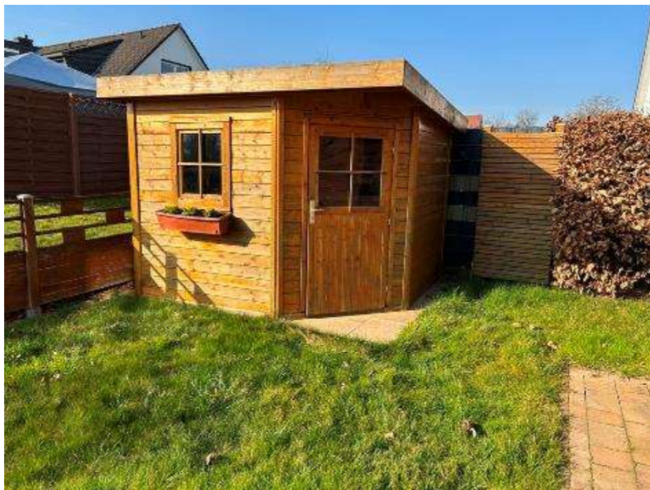
Südostansicht des Gartenhauses
