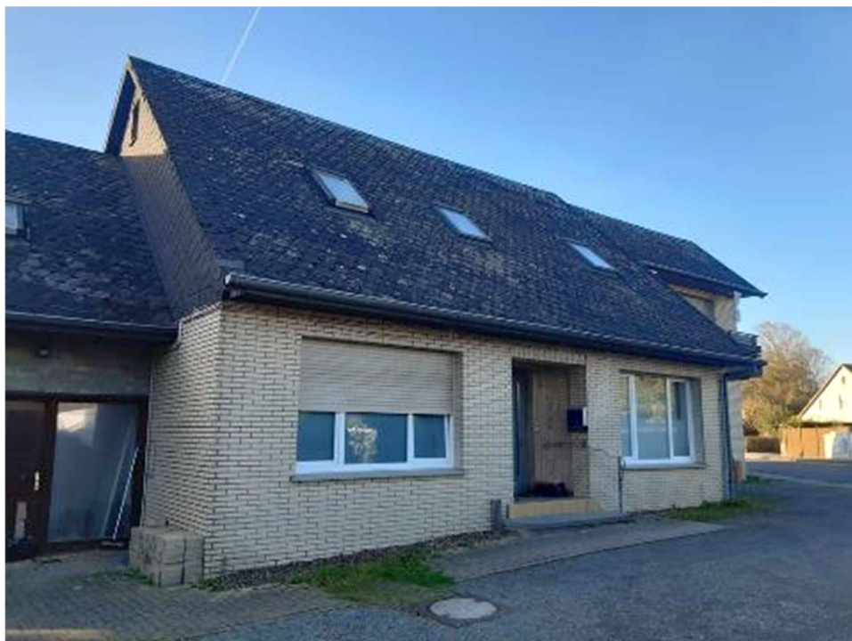
Südostansicht (Hofansicht) des Dreifamilienhauses
