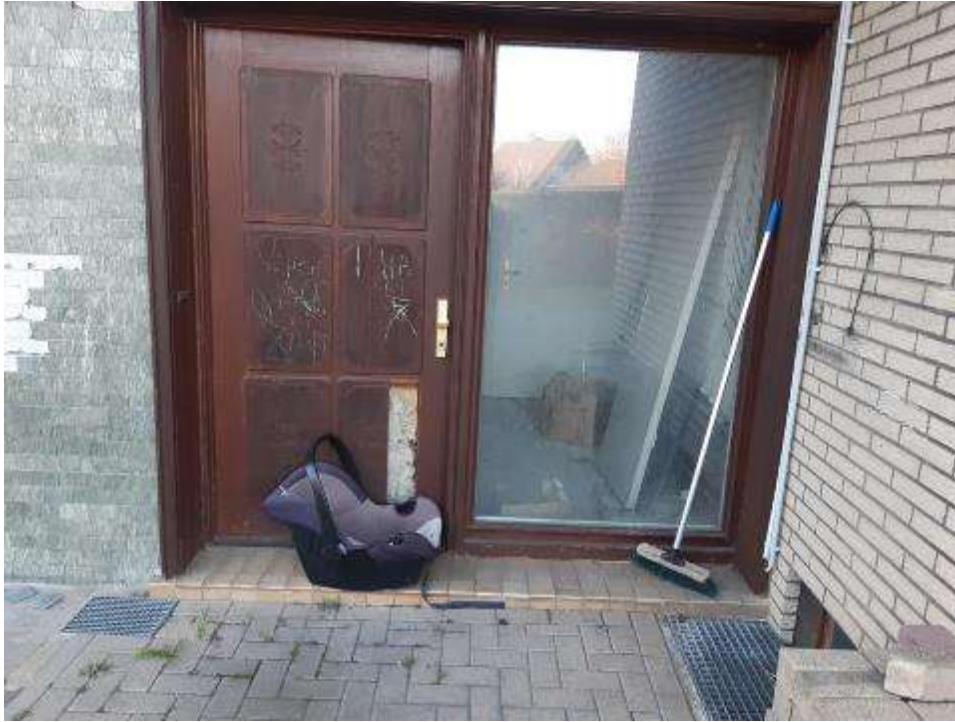
Ostansicht (Hofansicht) der Eingangstür des Anbaus
