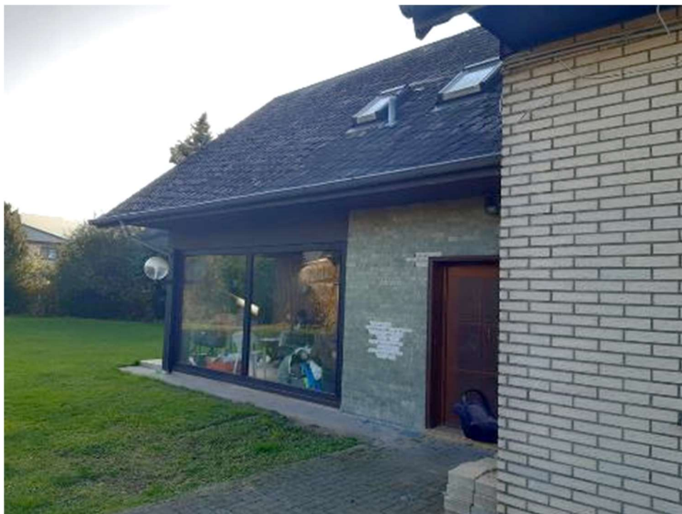
Nordostansicht (Hofansicht) des Anbaus mit überdachter Terrasse
