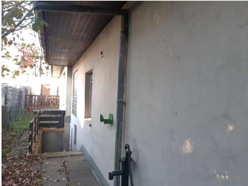
Südwestansicht (Rückansicht) des Anbaus
