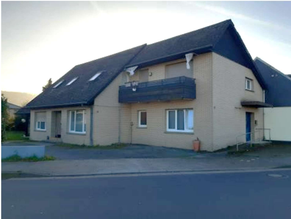
Nordostansicht (Straßenansicht) des Dreifamilienhauses
