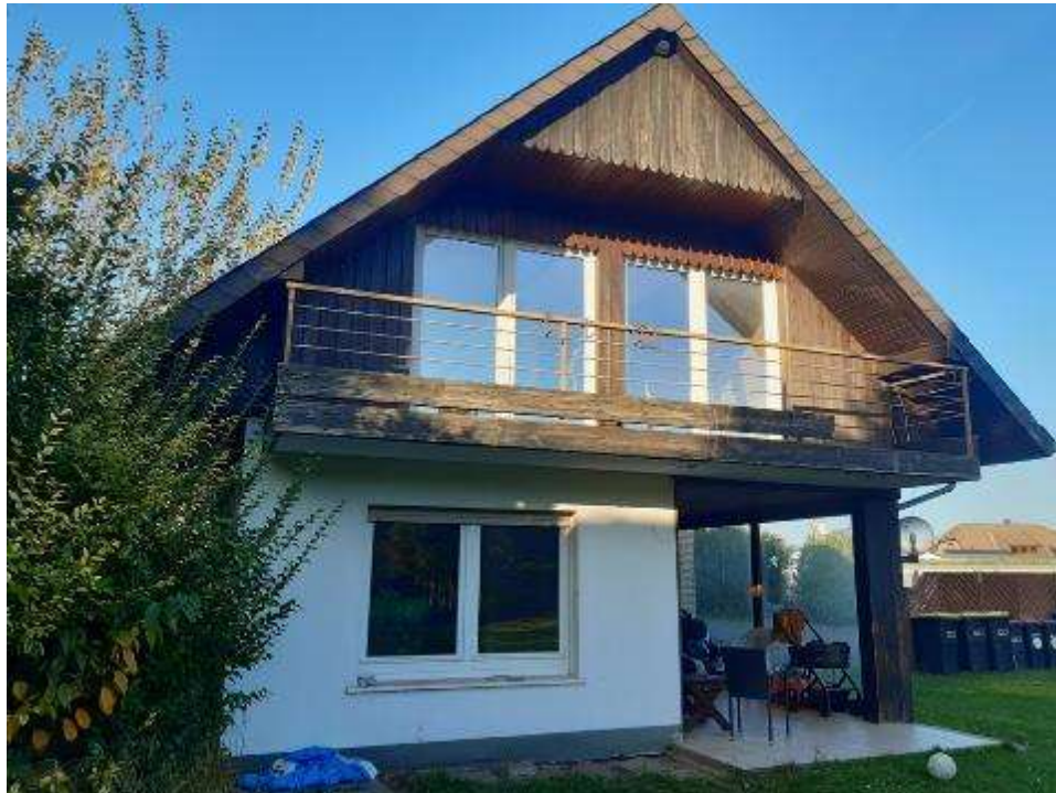
Südwestansicht (Rückansicht) des Anbaus mit überdachter Terrasse
