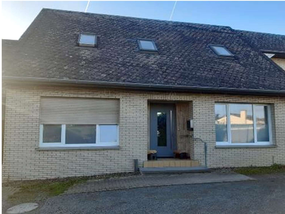
Ostansicht (Hofansicht) des Dreifamilienhauses
