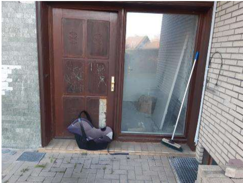
Ostansicht (Hofansicht) der Eingangstür des Anbaus
