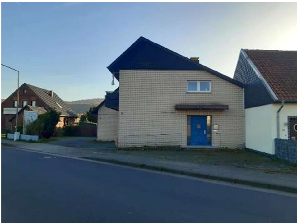
Nordansicht (Straßenansicht) des Dreifamilienhauses
