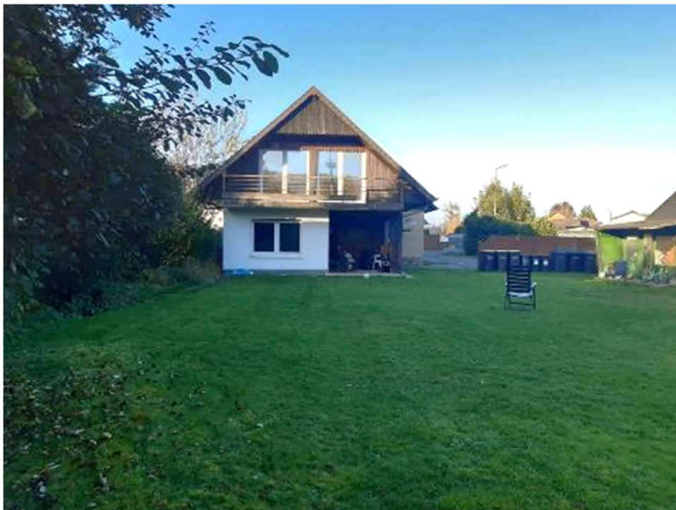
Südwestansicht (Rückansicht) des Anbaus
