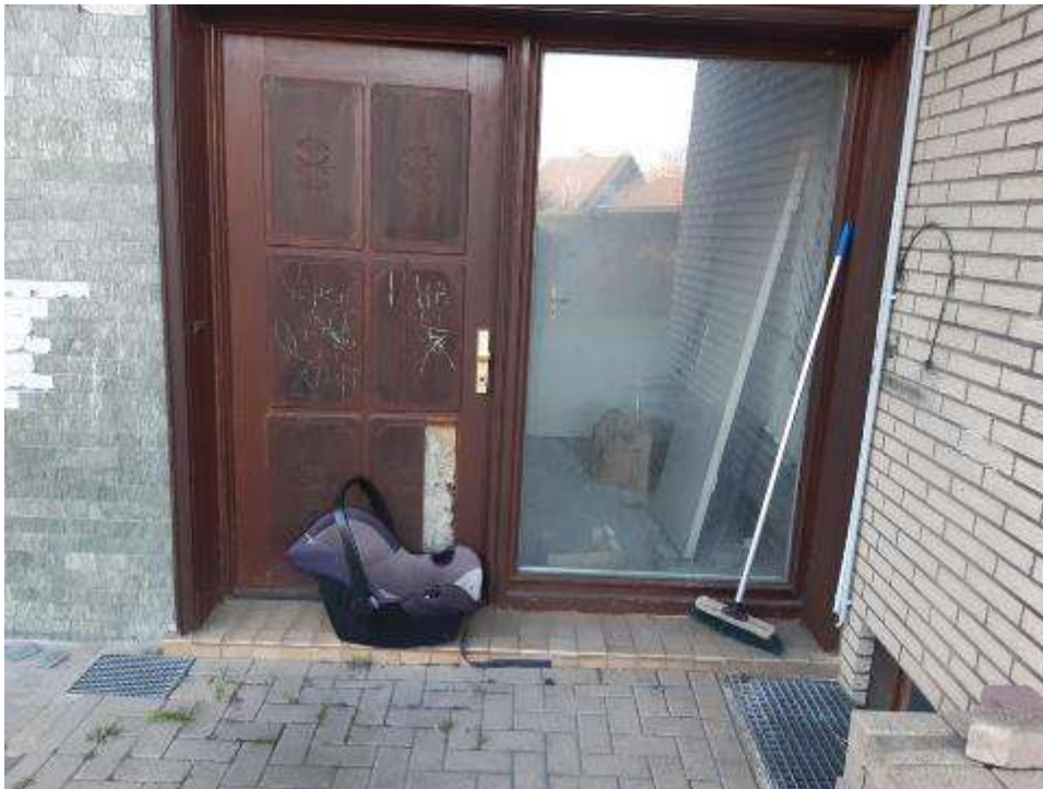
Ostansicht (Hofansicht) der Eingangstür des Anbaus
