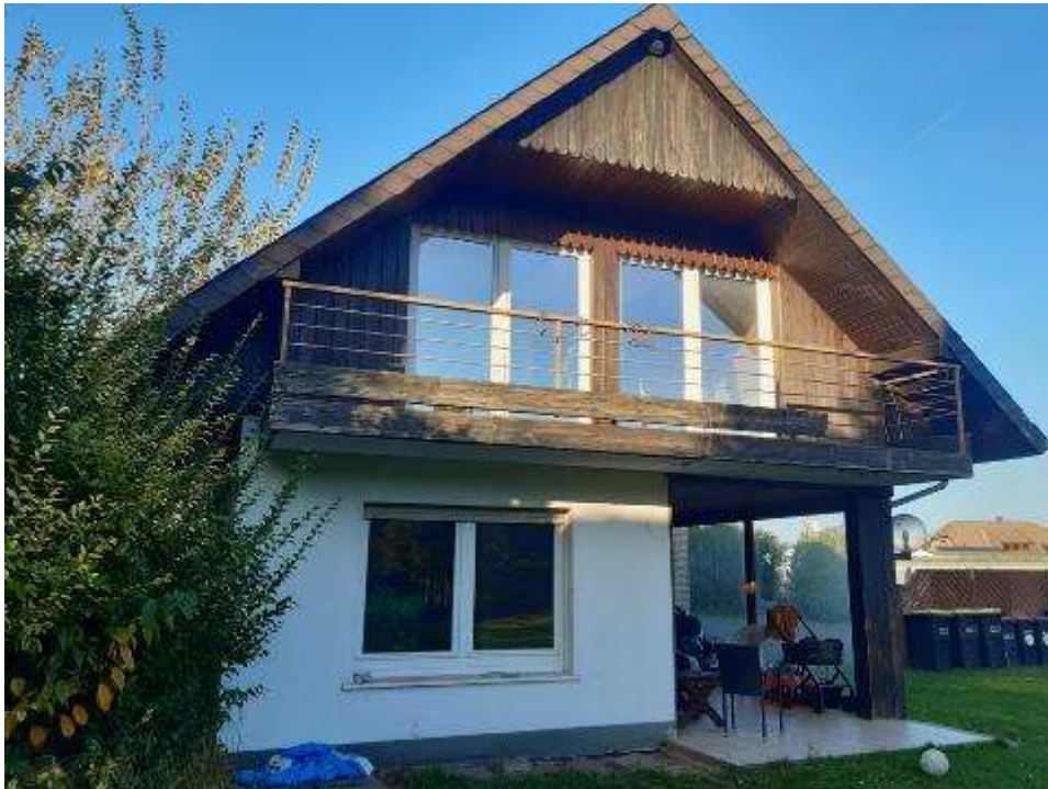
Südwestansicht (Rückansicht) des Anbaus mit überdachter Terrasse
