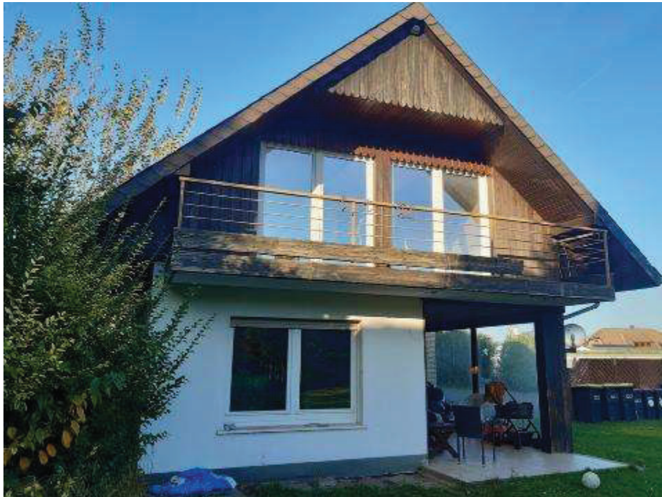
Südwestansicht (Rückansicht) des Anbaus mit überdachter Terrasse
