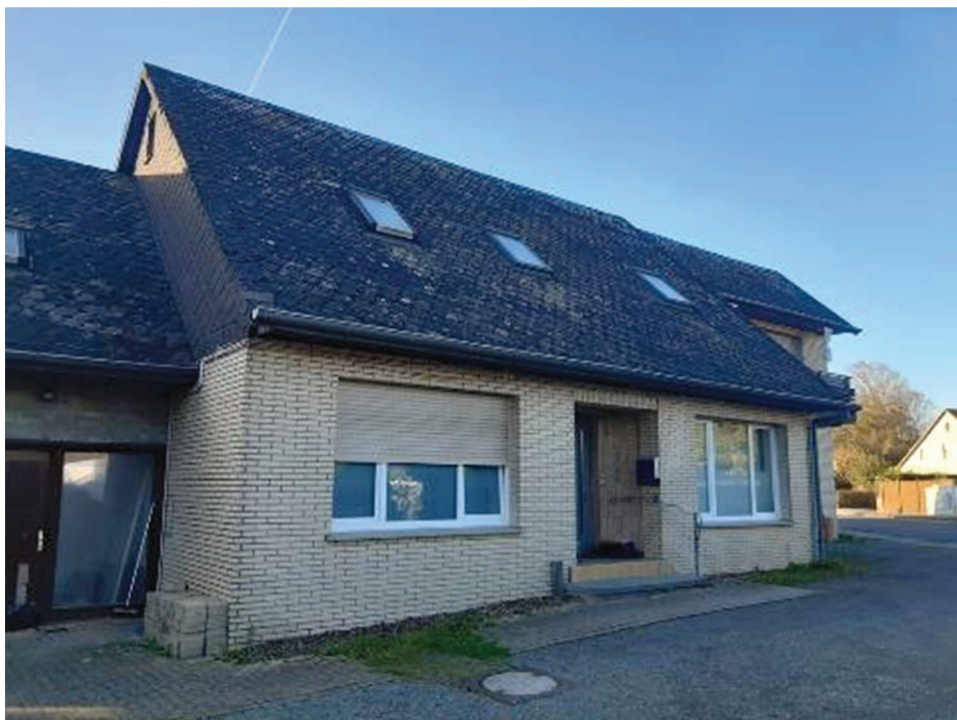
Südostansicht (Hofansicht) des Dreifamilienhauses
