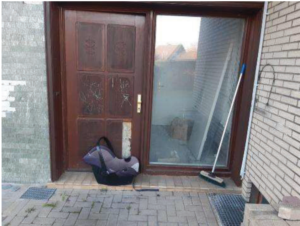
Ostansicht (Hofansicht) der Eingangstür des Anbaus
