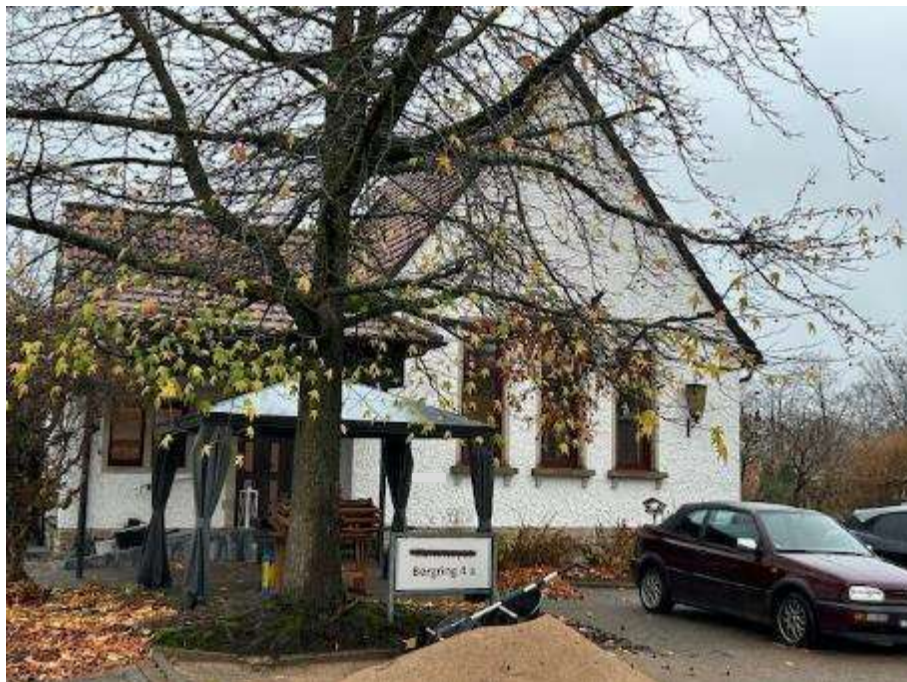
Ostansicht (Vorderansicht) des Einfamilienhauses (ehemaliges Kirchengebäude)
