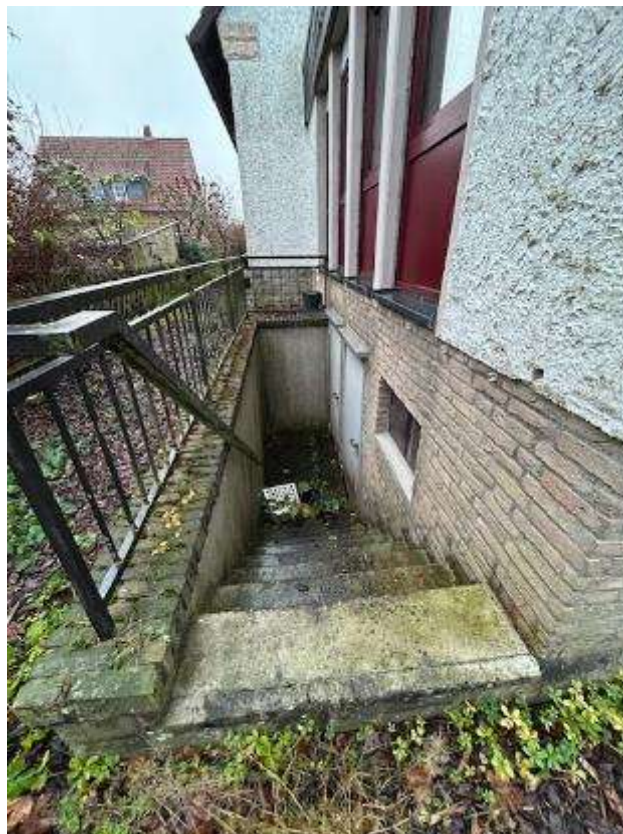
Westansicht der Kelleraußentreppe
