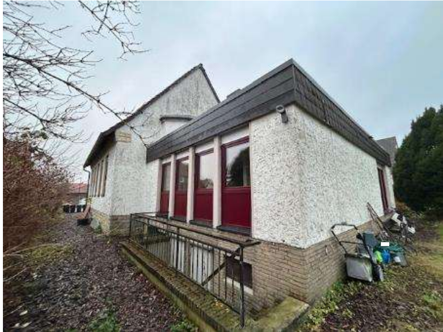
Nordwestansicht (Seiten- und Rückansicht) des Einfamilienhauses (ehemaliges Kirchengebäude)
