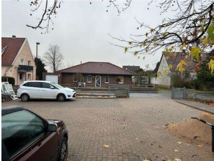
Westansicht (Hofansicht) der Zufahrt mit 7 Außen-Stellplätzen
