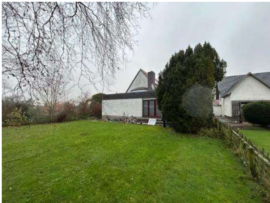
Südwestansicht (Rückansicht) des Einfamilienhauses (ehemaliges Kirchengebäude)
