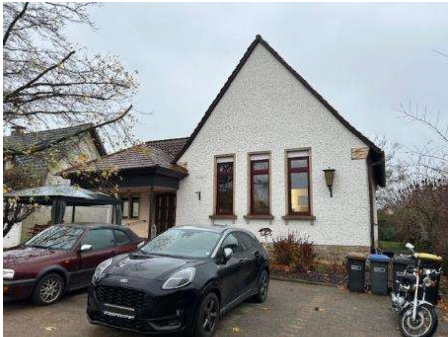
Nordostansicht (Vorderansicht) des Einfamilienhauses (ehemaliges Kirchengebäude)
