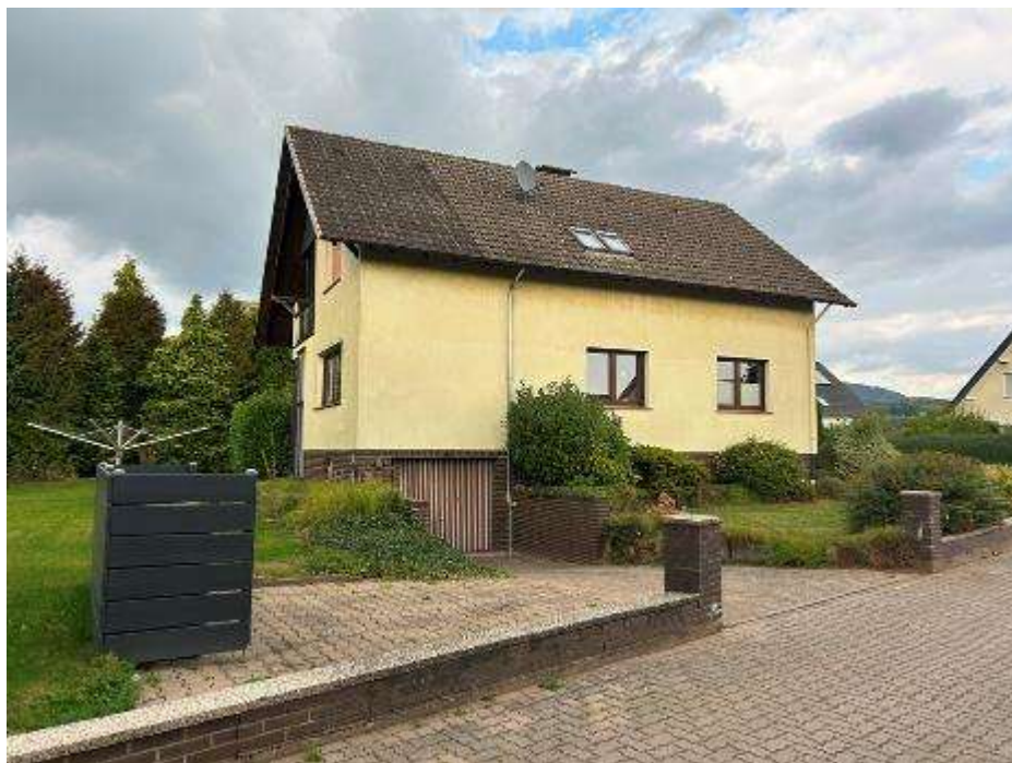
Südwestansicht (Straßenansicht) des Zweifamilienhauses mit Kellergarage
