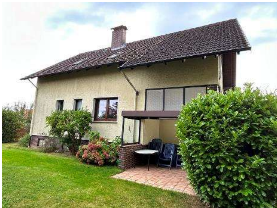
Nordwestansicht (Rückansicht) des Zweifamilienhauses
