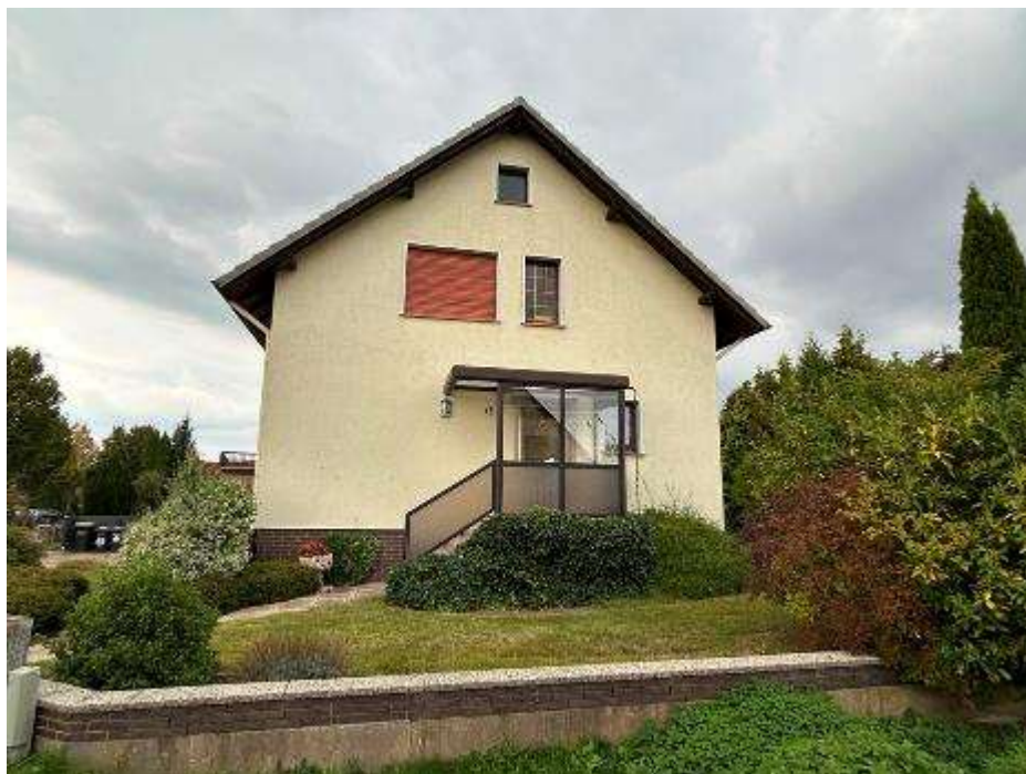
Ostansicht (Straßenansicht) des Zweifamilienhauses
