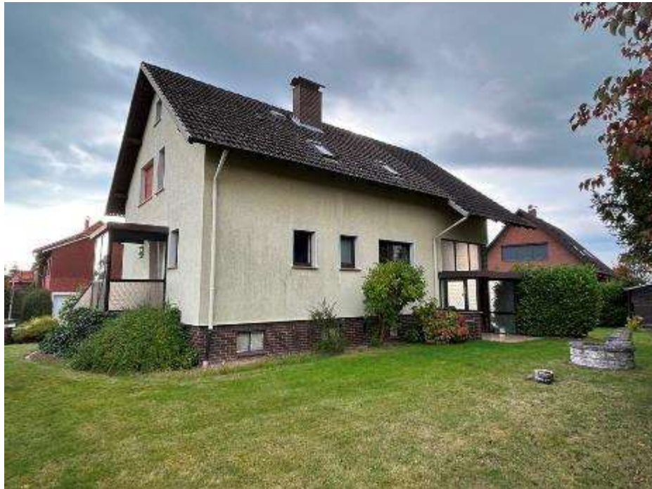
Nordostansicht (Gartenansicht) des Zweifamilienhauses
