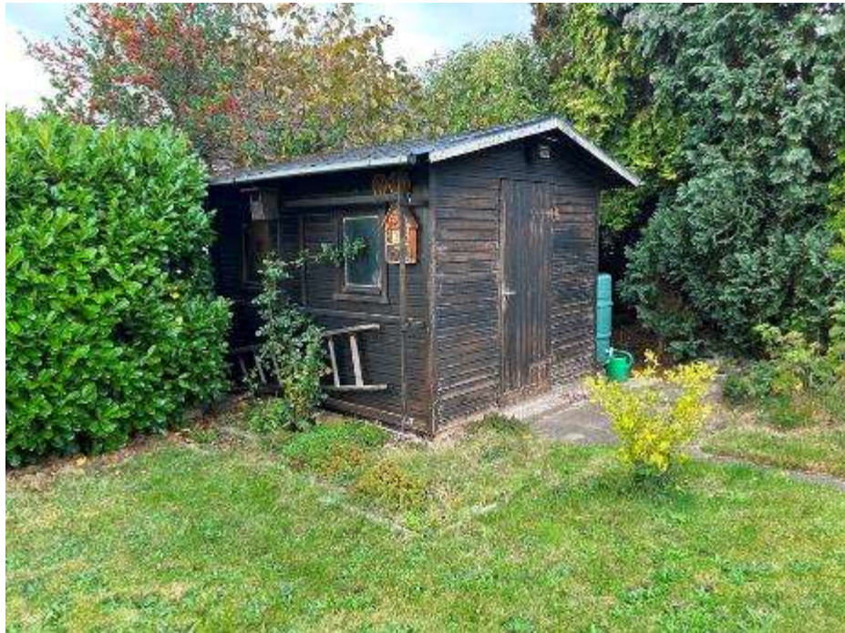
Südostansicht des Gartenhauses
