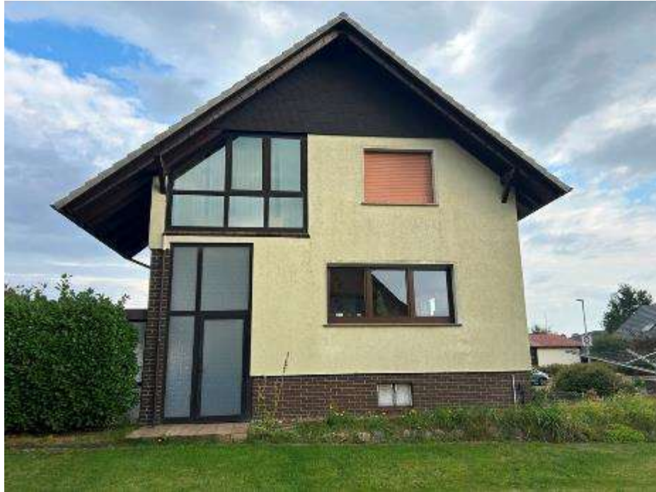
Westansicht (Seitenansicht) des Zweifamilienhauses
