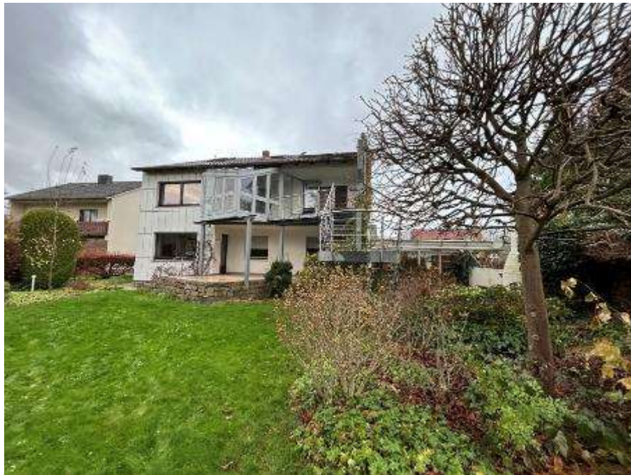
Südansicht (Rückansicht) des Zweifamilienhauses mit Doppelgarage
