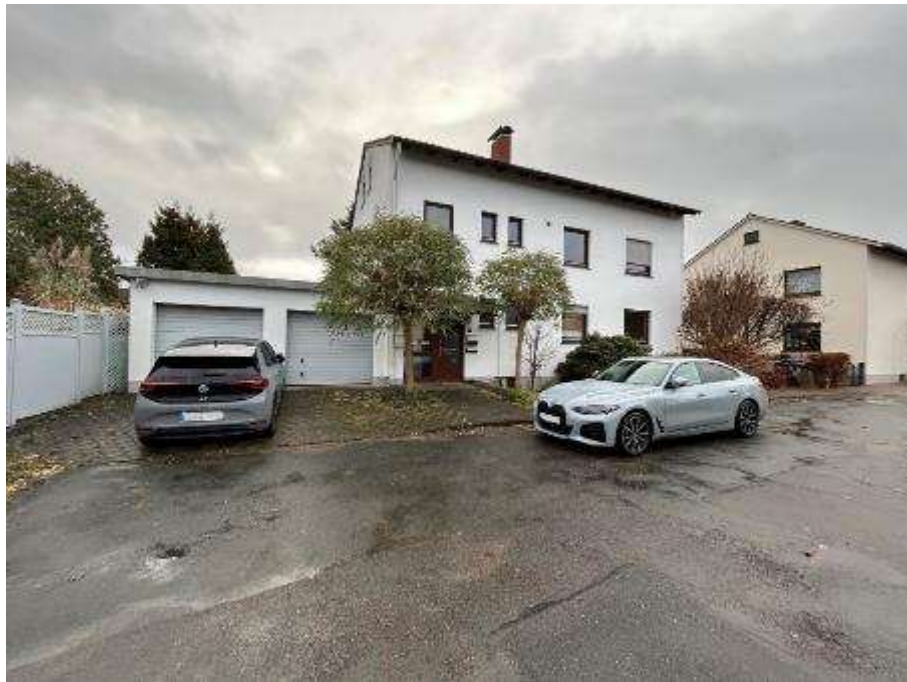
Nordostansicht (Straßenansicht) des Zweifamilienhauses mit Doppelgarage
