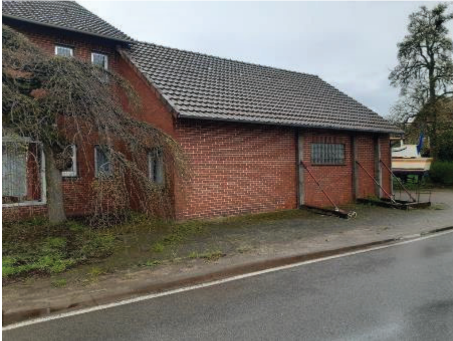
Westansicht (Straßenansicht) des Werkstattanbaus
