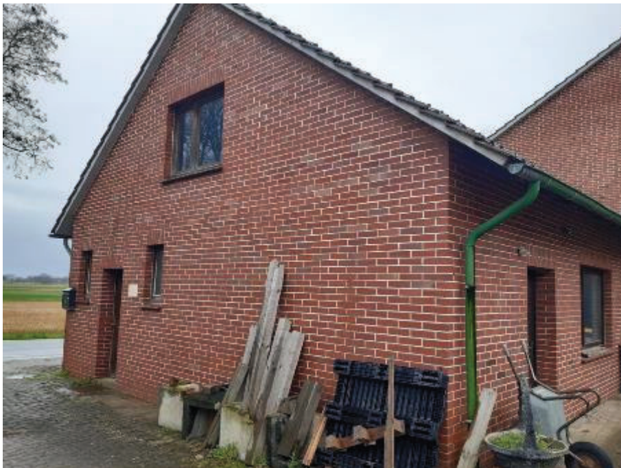
Ostansicht (Hofansicht) des Werkstattanbaus
