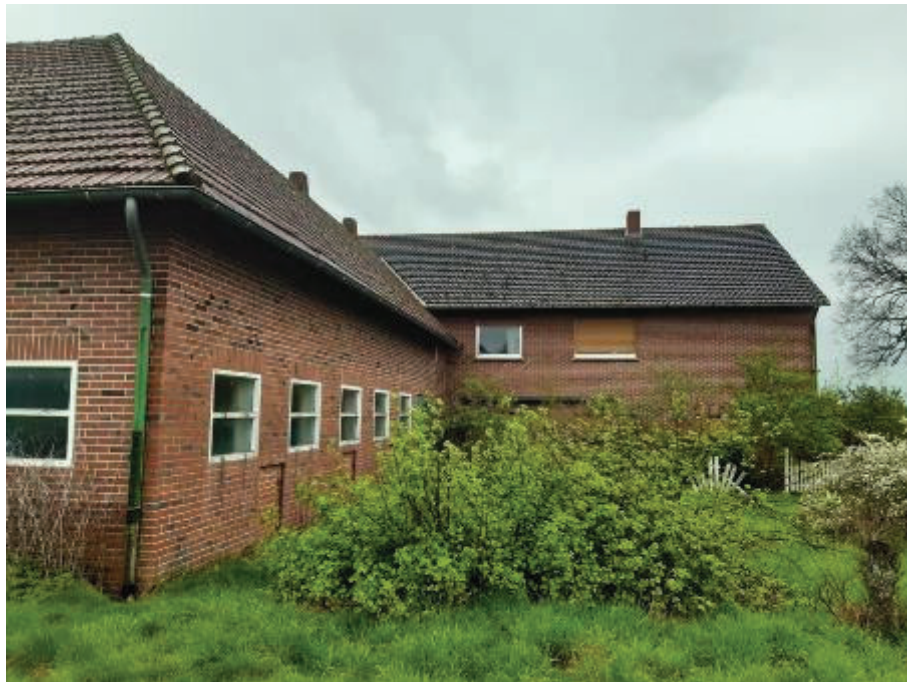
Nordansicht (Rückansicht) des Wohnhauses und des ehem. Stalls
