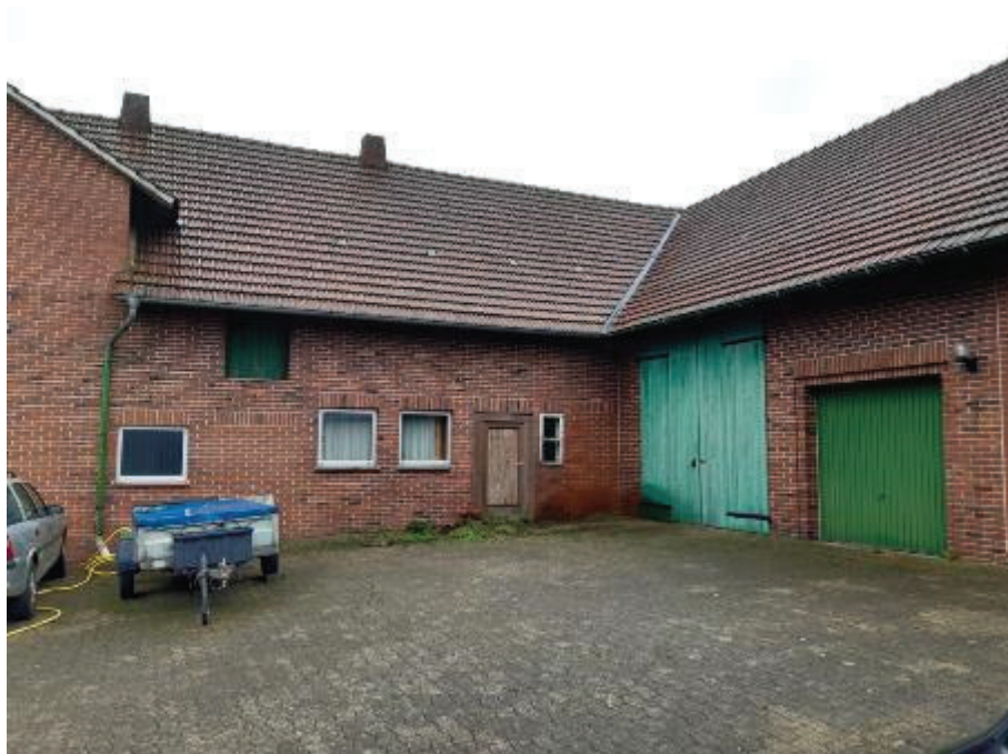
Südostansicht (Hofansicht) des Resthofes mit Wohnhaus, Stall und Scheunenbauten
