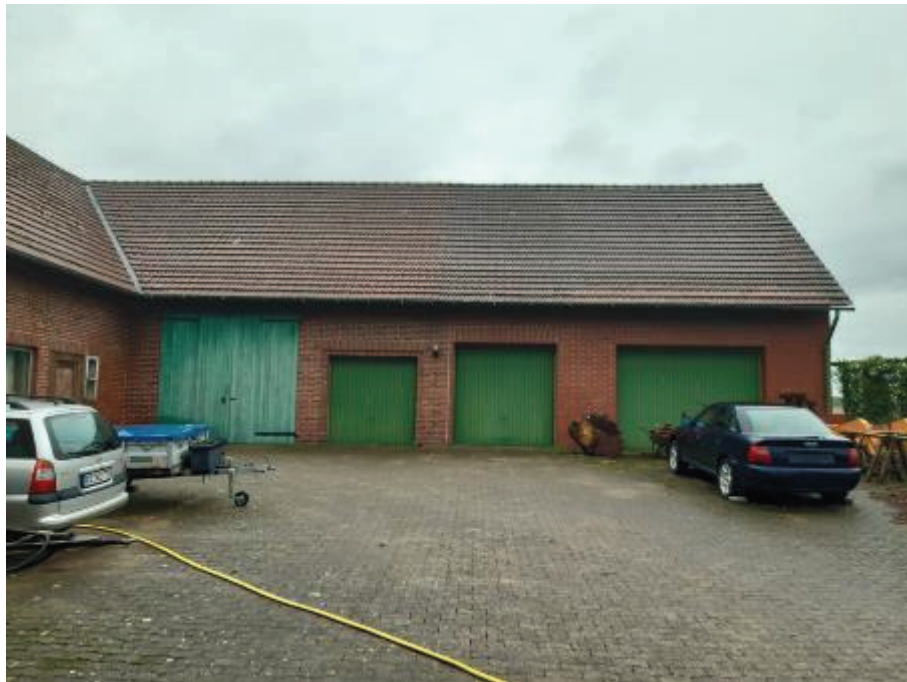
Südwestansicht (Hofansicht) des Resthofes Scheune mit Garagen
