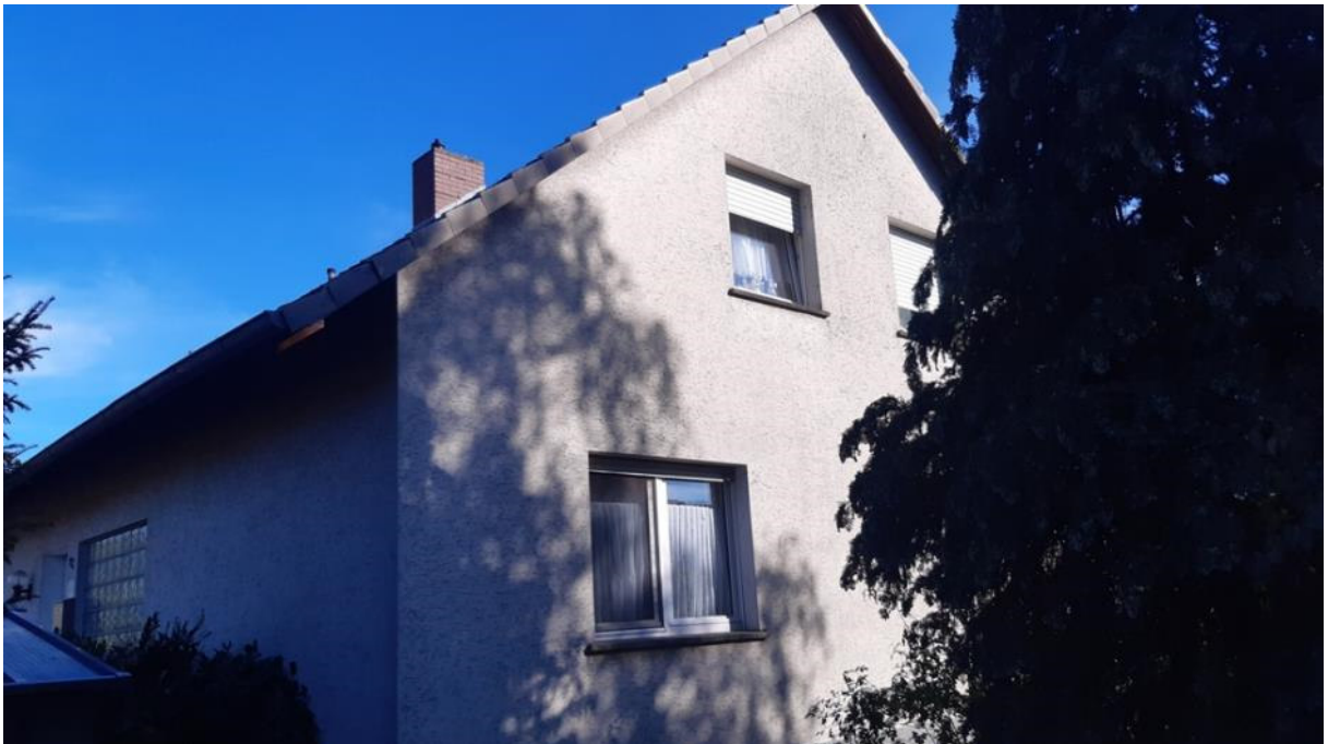
Nordwestansicht (Seitenansicht) des Ein/Zweifamilienhauses
