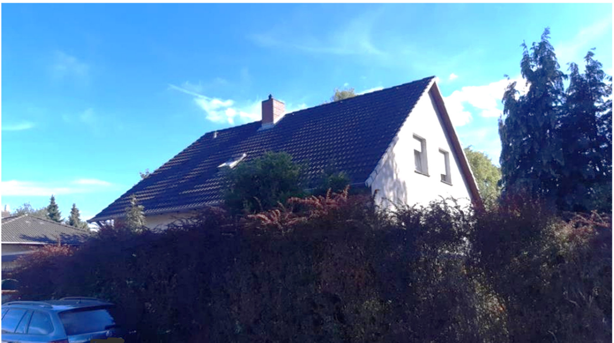
Nordwestansicht (Straßenansicht) des Ein/Zweifamilienhauses
