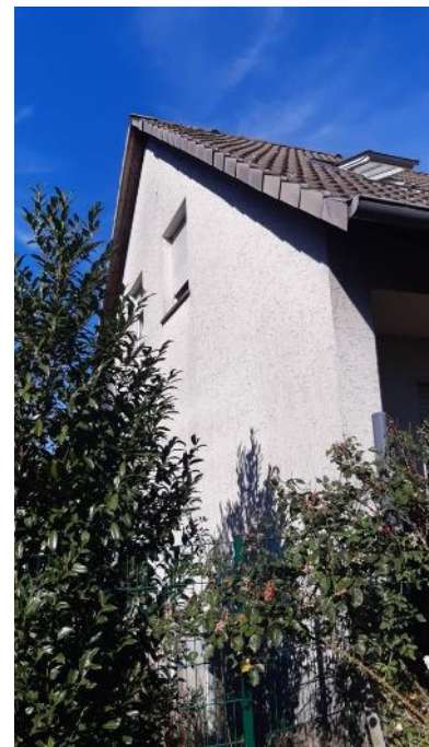
Südwestansicht (Seitenansicht) des Ein/Zweifamilienhauses
