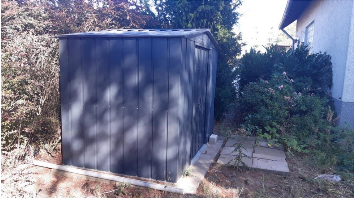
Westansicht des Schuppens und des Einfamilienhauses
