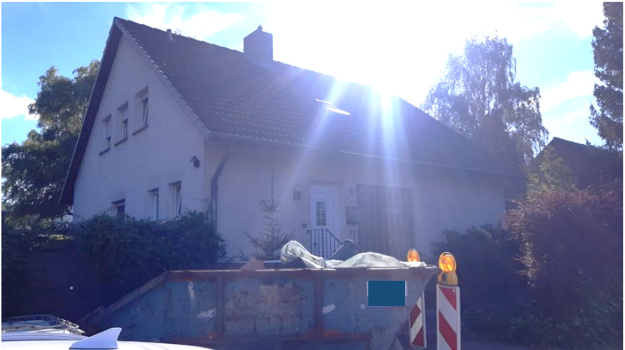
Nordostansicht (Straßenansicht) des Ein/Zweifamilienhauses
