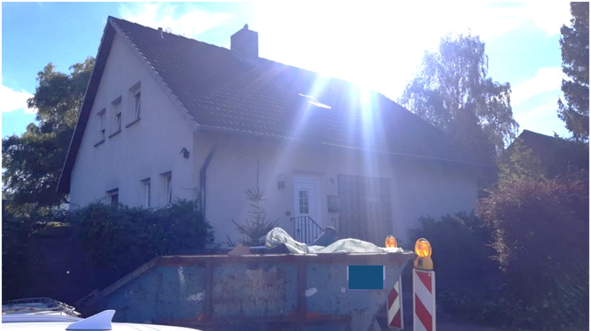
Nordostansicht (Straßenansicht) des Ein/Zweifamilienhauses
