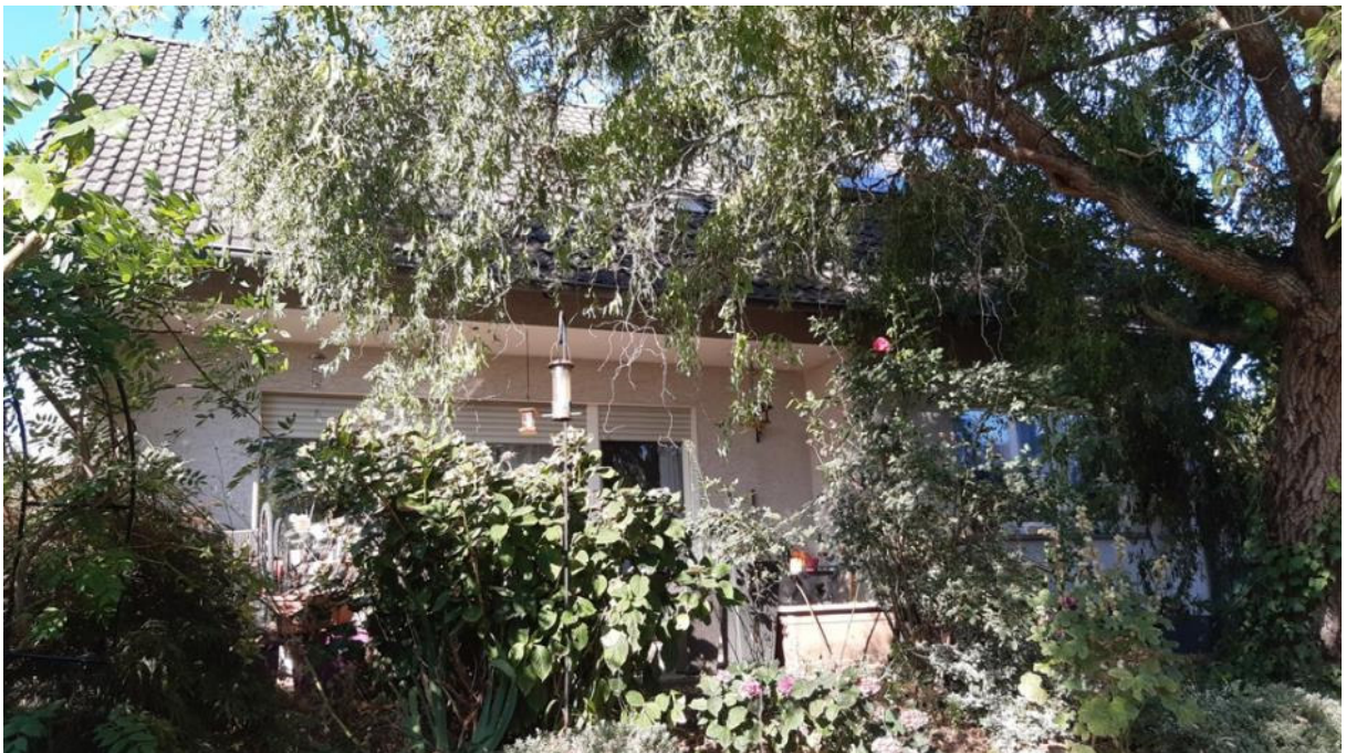
Südwestansicht (Rückansicht) des Ein/Zweifamilienhauses
