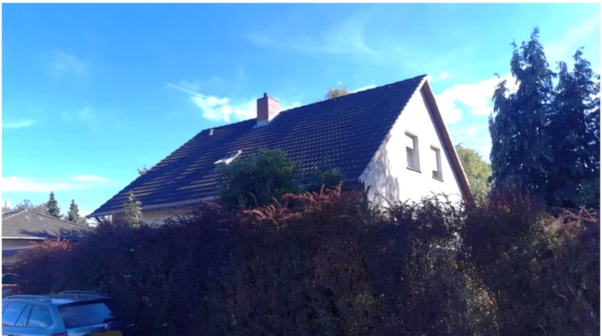
Nordwestansicht (Straßenansicht) des Ein/Zweifamilienhauses
