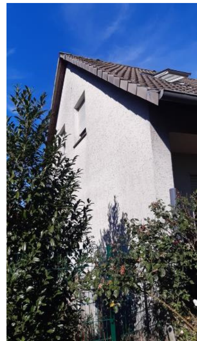
Südwestansicht (Seitenansicht) des Ein/Zweifamilienhauses
