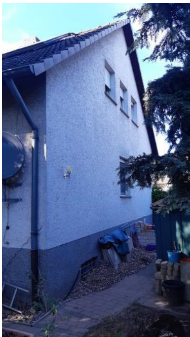
Südostansicht (Seitenansicht) des Ein/Zweifamilienhauses
