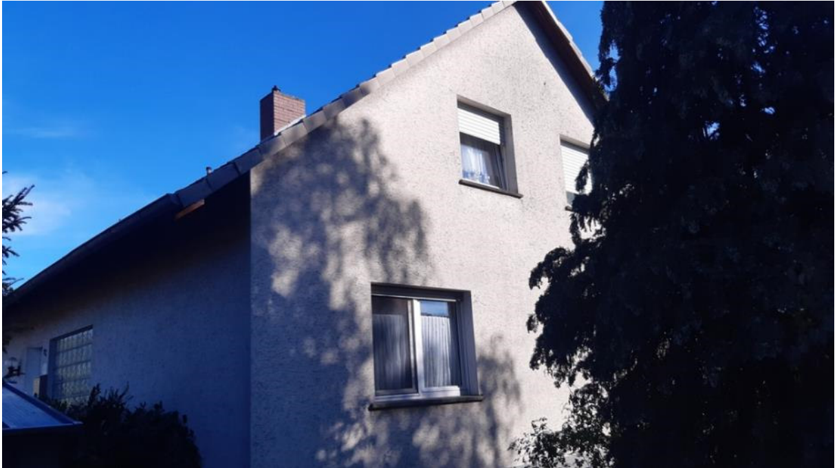
Nordwestansicht (Seitenansicht) des Ein/Zweifamilienhauses
