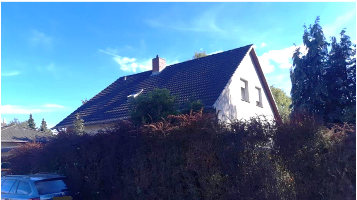
Nordwestansicht (Straßenansicht) des Ein/Zweifamilienhauses
