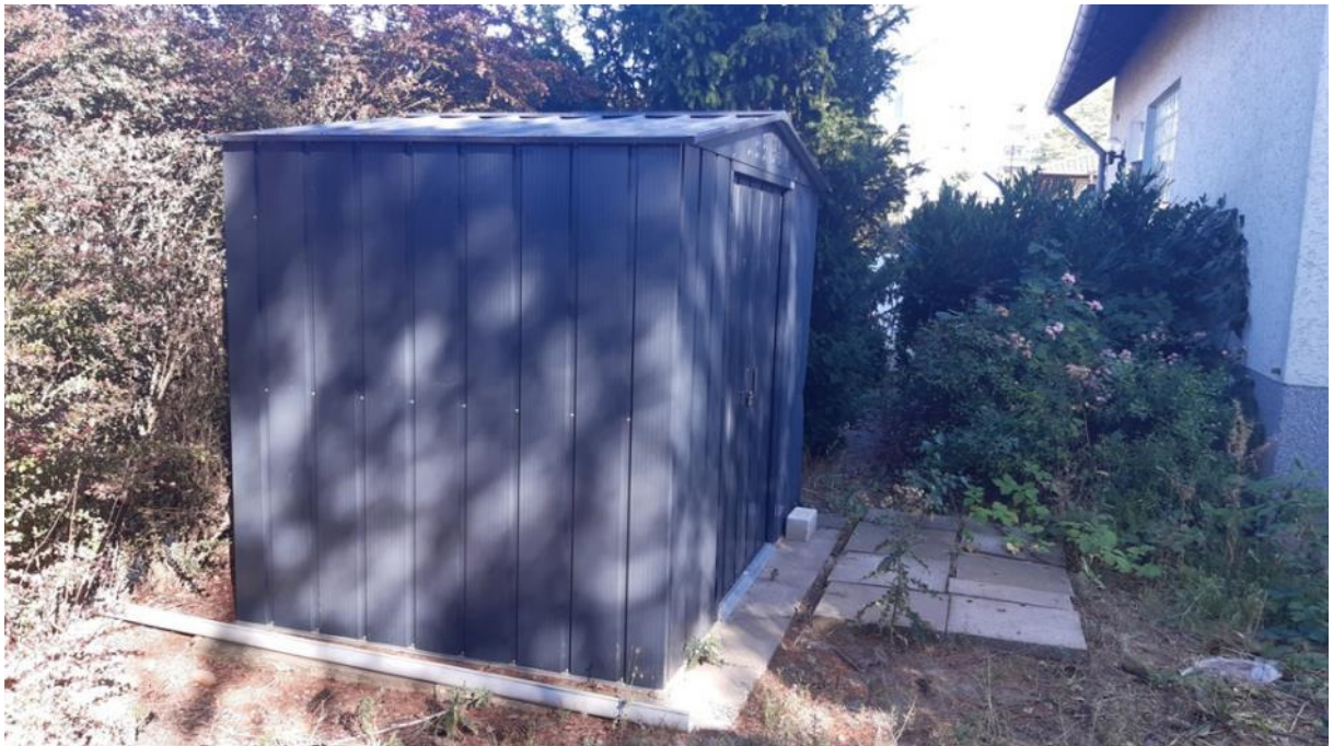
Westansicht des Schuppens und des Einfamilienhauses
