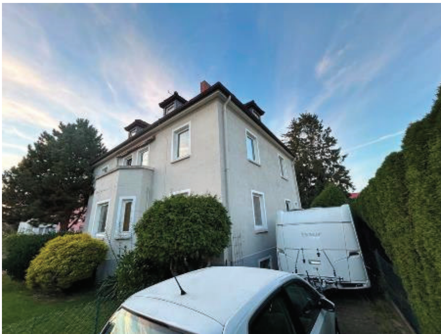
Südostansicht (Straßenansicht) des Zweifamilienhauses
