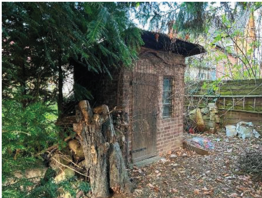
Südwestansicht des Schuppens
