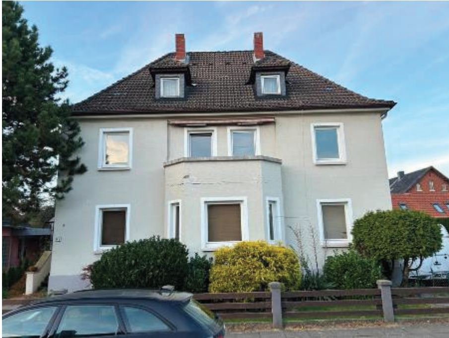
Südansicht (Straßenansicht) des Zweifamilienhauses
