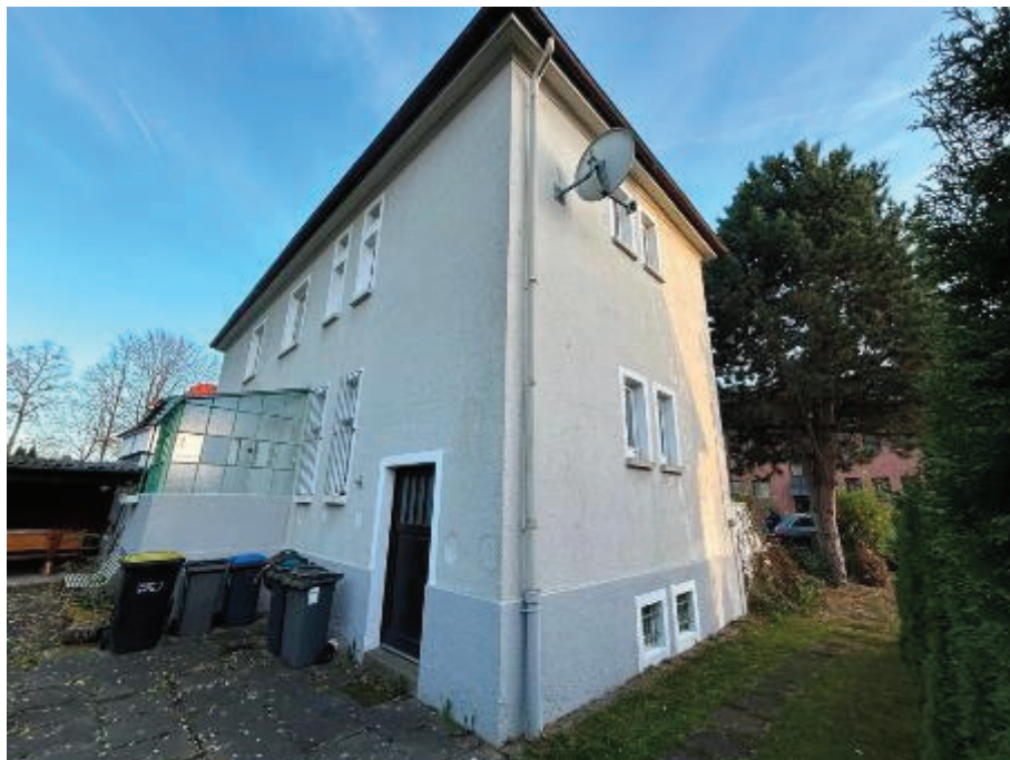
Nordwestansicht (Gartenansicht) des Zweifamilienhauses
