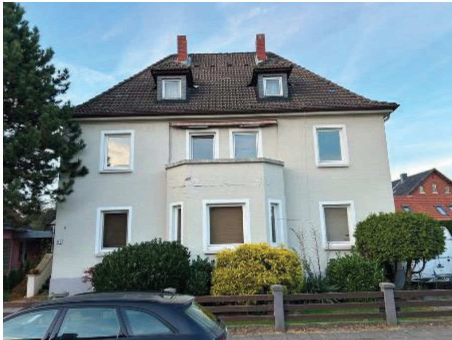
Südansicht (Straßenansicht) des Zweifamilienhauses
