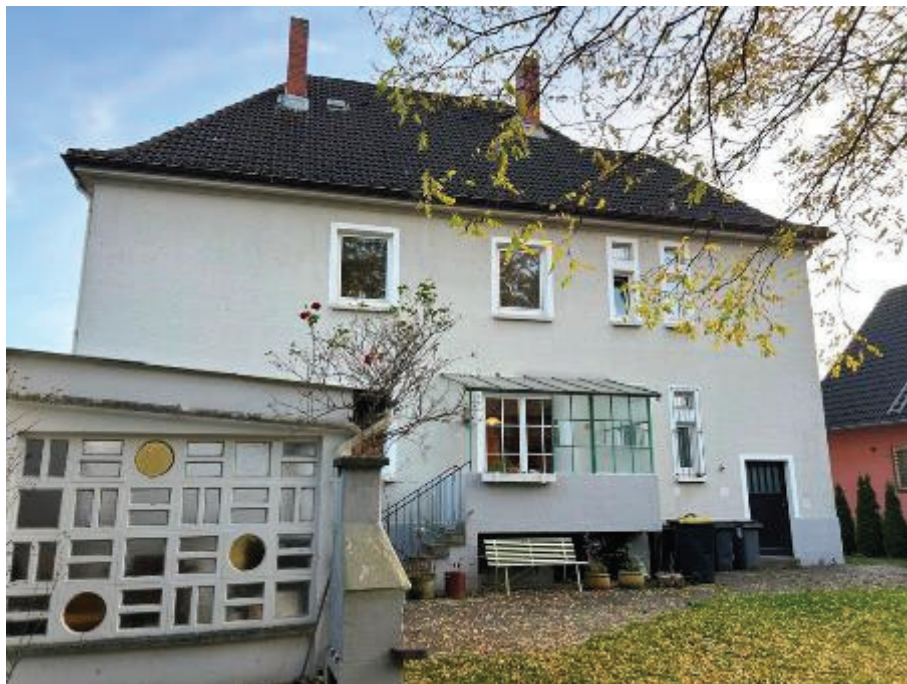
Nordansicht (Rückansicht) des Zweifamilienhauses
