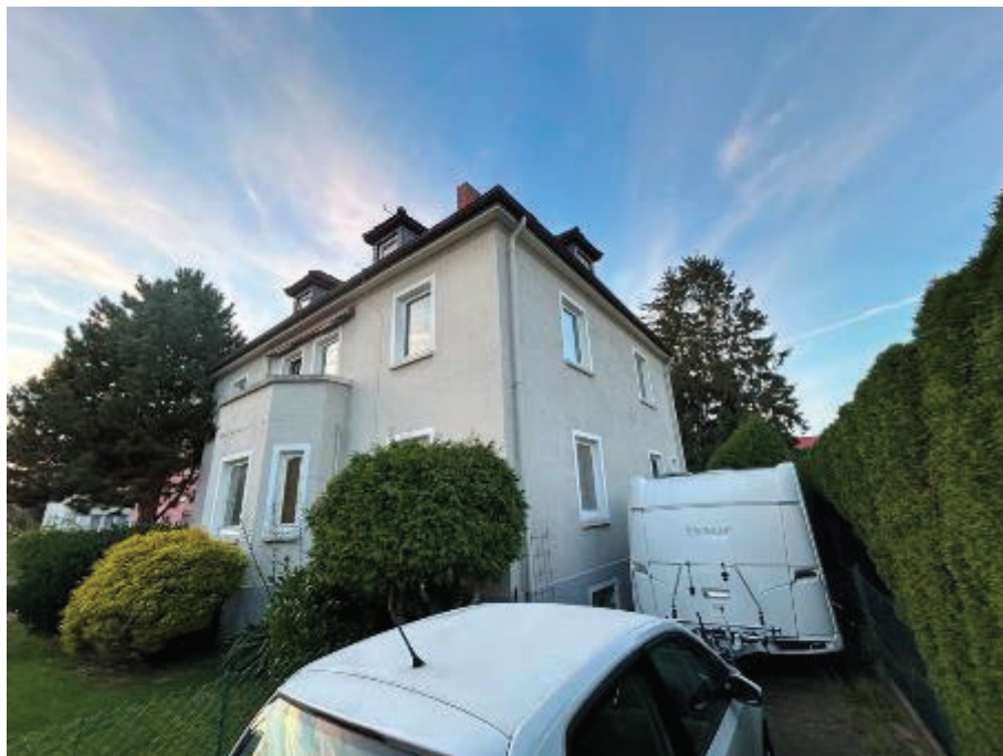
Südostansicht (Straßenansicht) des Zweifamilienhauses
