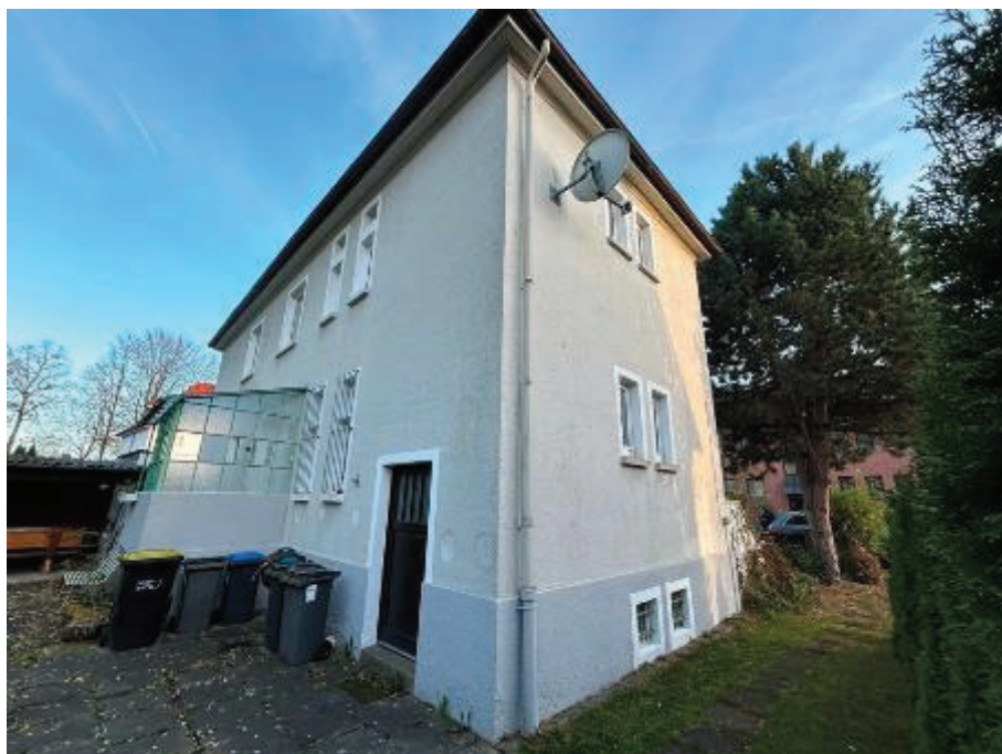
Nordwestansicht (Gartenansicht) des Zweifamilienhauses
