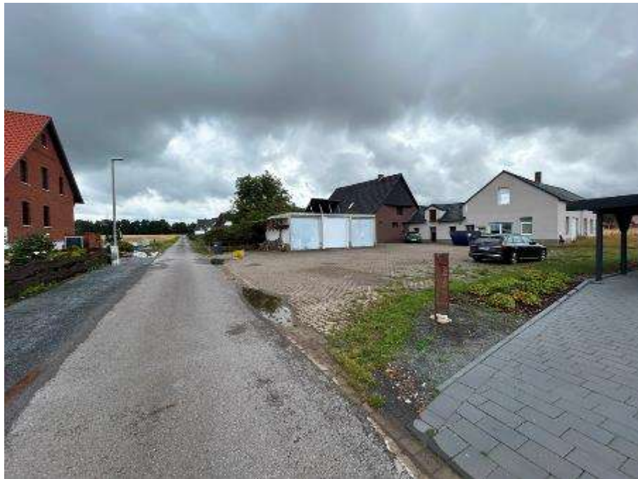
Nordostansicht (Straßenansicht) des Produktionsgebäudes mit Erschließungsstraße und Umgebungsbebauung
