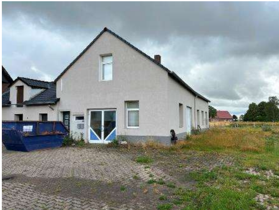
Nordostansicht (Vorderansicht) des Produktionsgebäudes - Werkstatt -
