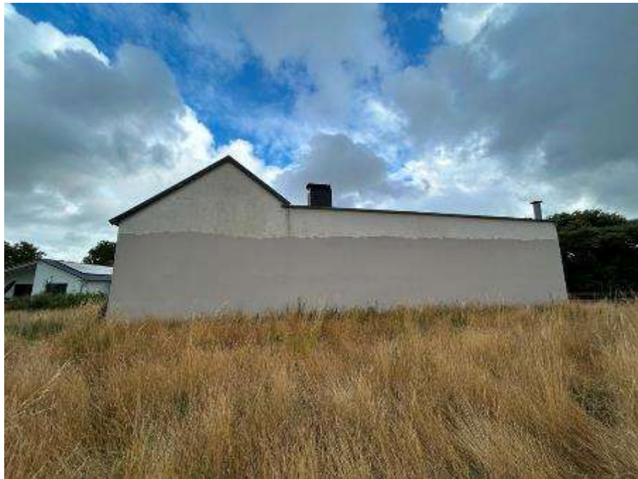
Westansicht (Rückansicht) des Produktionsgebäudes - Werkstatt -
