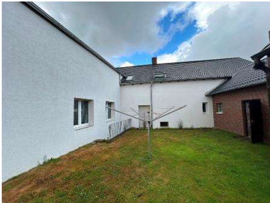
Südansicht (Hofansicht) des Produktionsgebäudes - Werkstatt -
