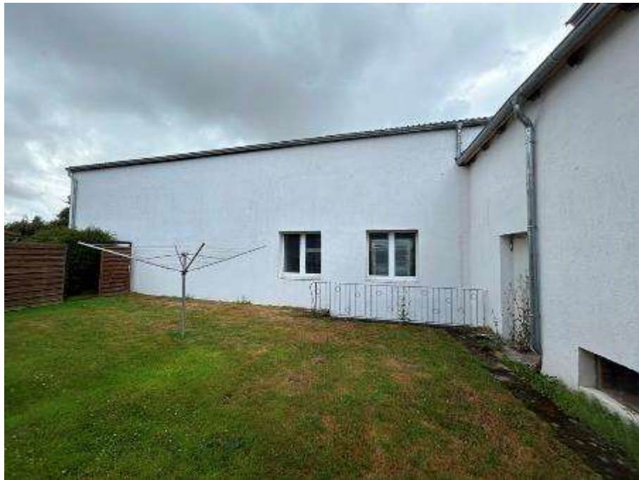
Ostansicht (Hofansicht) des Produktionsgebäudes - Werkstatt -
