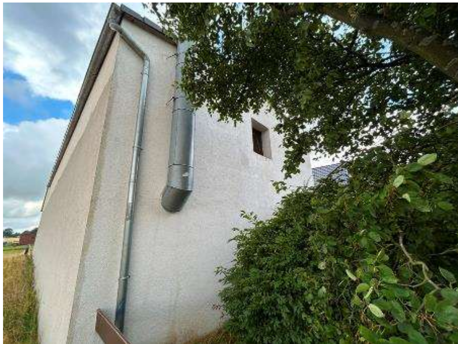
Südwestansicht (Rückansicht) des Produktionsgebäudes - Werkstatt -
