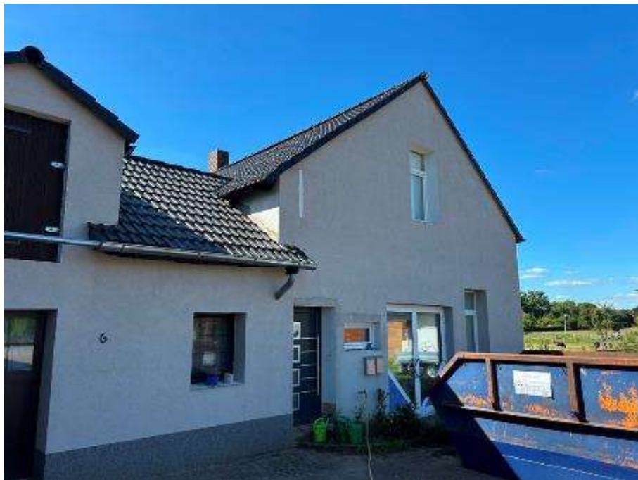
Südostansicht (Vorderansicht) des Produktionsgebäudes - Werkstatt -
