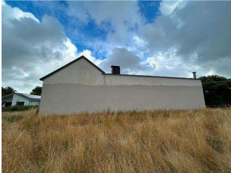
Westansicht (Rückansicht) des Produktionsgebäudes - Werkstatt -
