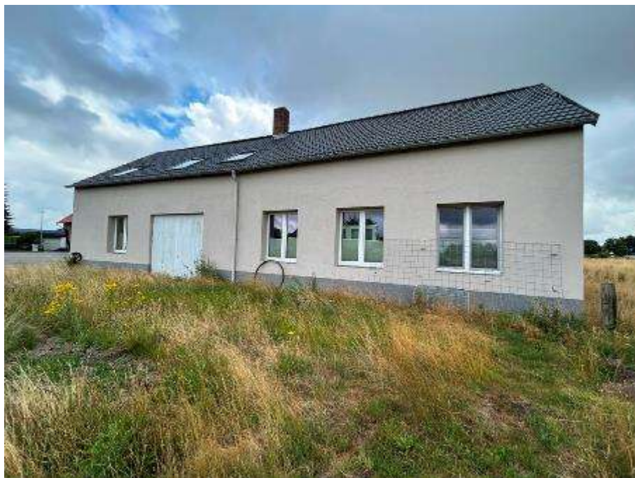
Nordwestansicht (Seitenansicht) des Produktionsgebäudes - Werkstatt -
