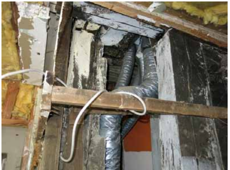
Haus-Nr. 44, OG; Beispiel W 3: Installationsschacht: Brandschutz und Schallschutz beachten!
