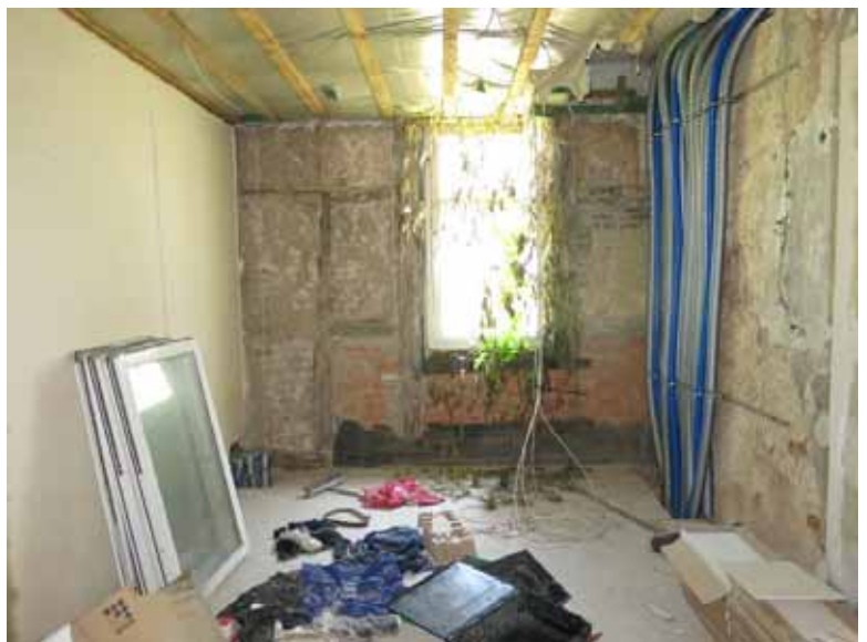
Haus-Nr. 44, Beispiel W 2: Zimmer Ostseite; Fachwerkkonstruktion Außenwand erkennbar
