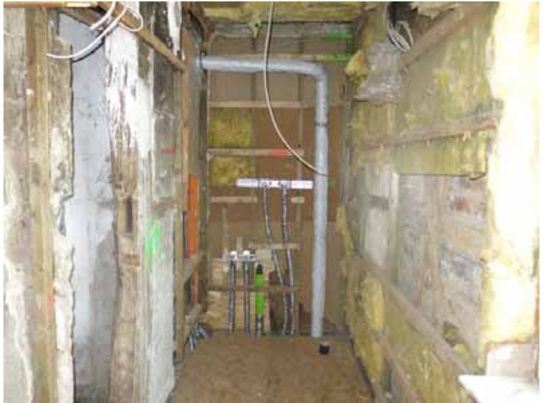
Haus-Nr. 44, OG; Beispiel W 3: Installationsschacht: Brandschutz und Schallschutz beachten!
