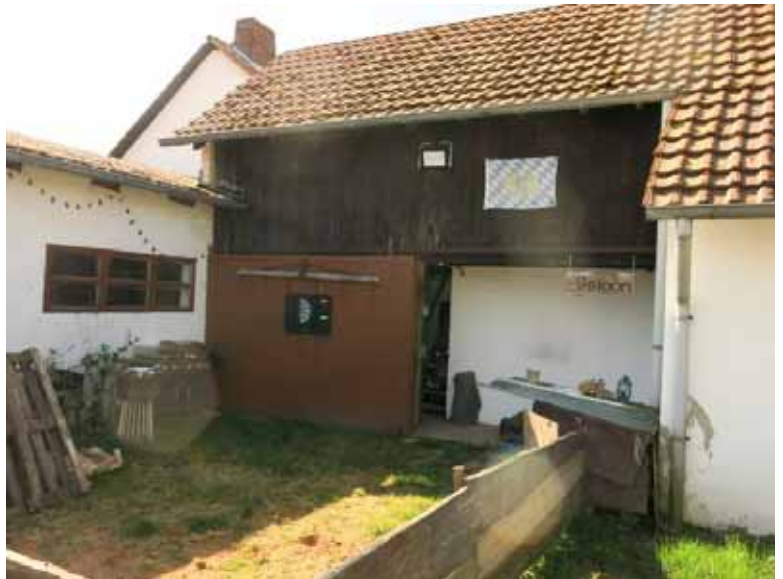
Ansicht von Norden, links Stall / Scheune B) , rechts Stallung C) mittig der Zwischenbau
