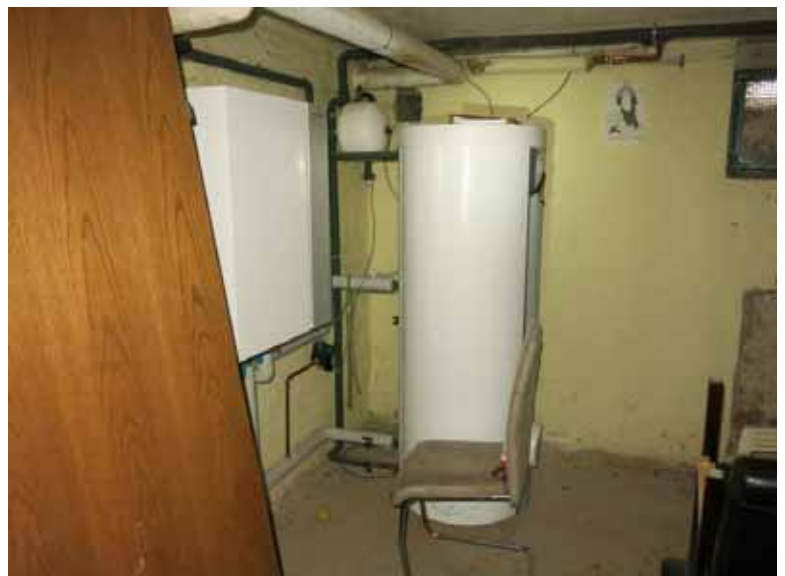
Beispiel Keller, mit Wärmepumpen-Verdampfer und WW-Speicher rechts Feuchtebilder an Außenwand
