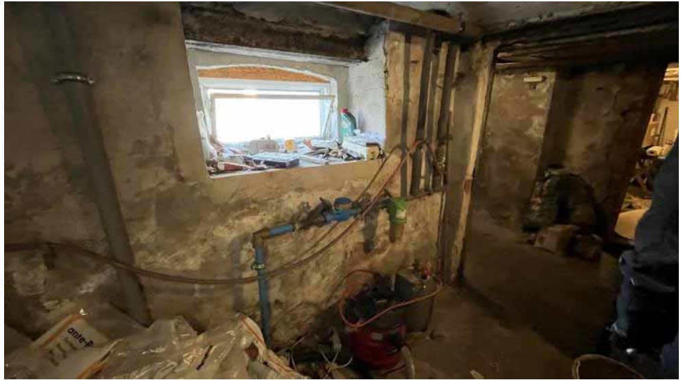
Beispiel Kellerraum (Wasser- + Heizungs-Installationen)
