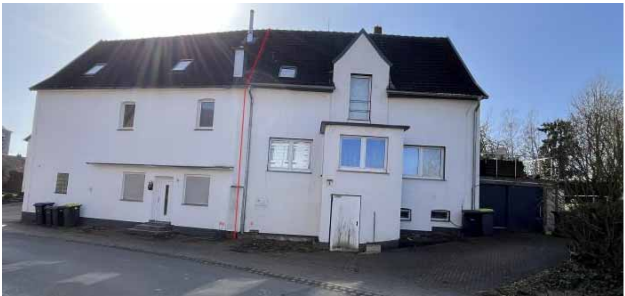
Ansicht von Norden; links Hs-Nr. 9a, rechts Hs-Nr. 9 mit Garage
