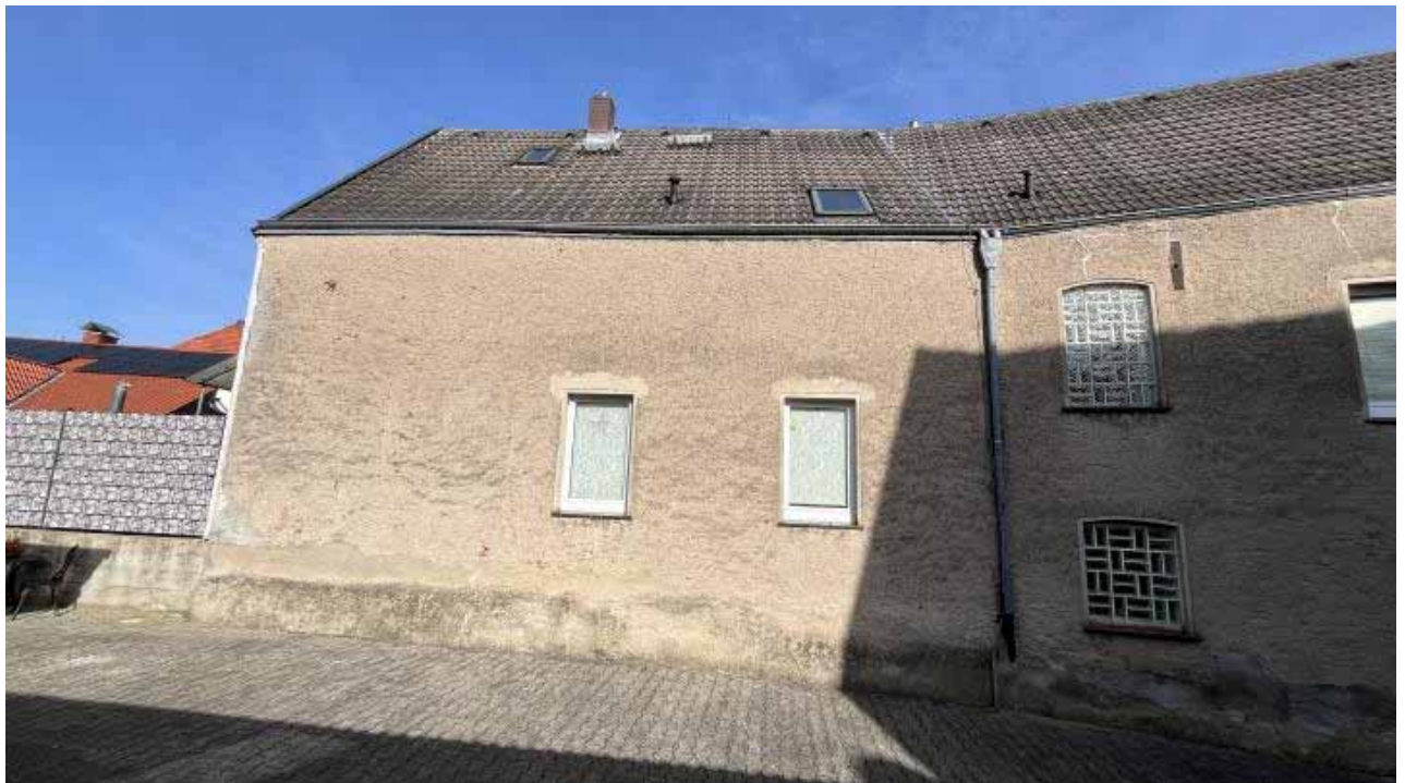
Frohnhauser Str. 9 (links) und 9a (rechts), Ansicht von Süden (Nachbargrundstück) Das Haus steht unmittelbar auf der grenze (tlw. auch leicht über die Grenze überbaut)
