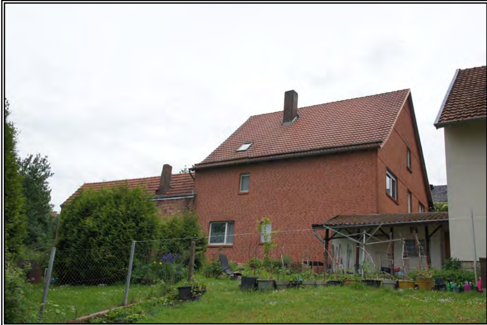
Seitenansicht von Norden
