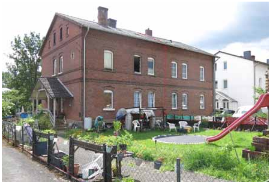
Haus-Nr. 9 = linke Haushälfte
