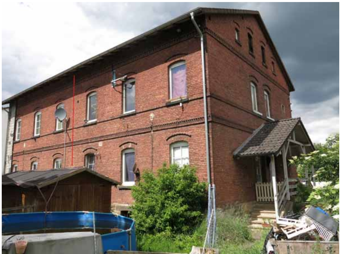
Scherfeder Str. 9 ( rechte Haushälfte!), Ansicht von Südwesten
