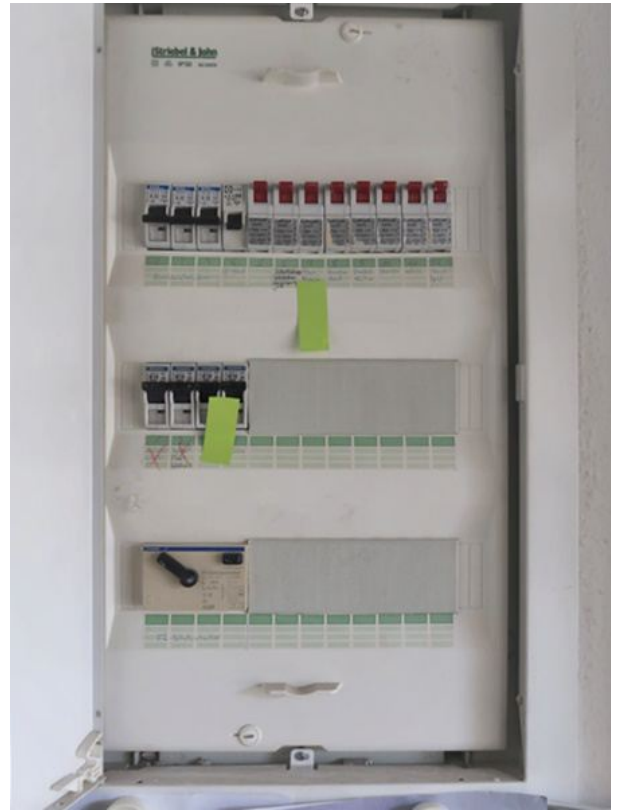
Elektrounterverteilung
