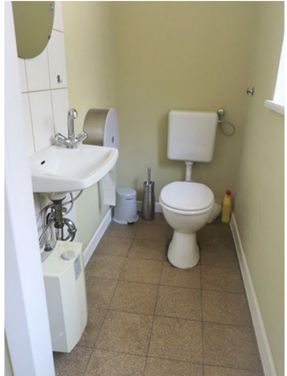
WC-Raum mit Zugang vom Treppenhaus, zur gemeinsamen Nutzung für die beiden Ladenflächen
