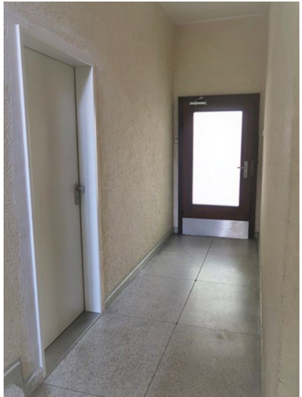
Treppenhaus mit Hauseingangstür
