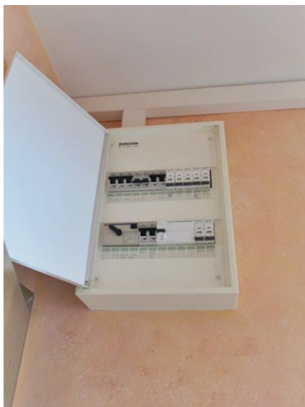
Elektrounterverteilung
