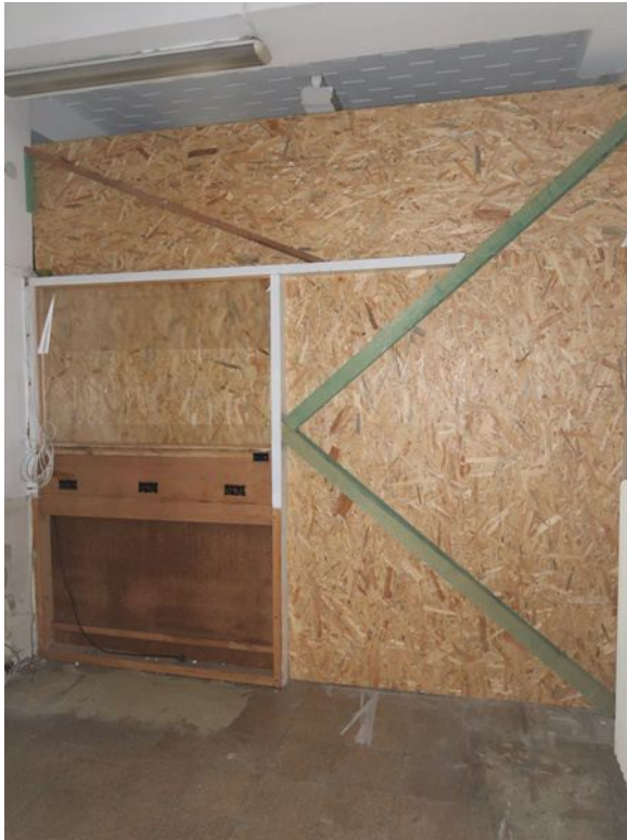
Provisorische Trennwand zwischen Verkaufsraum und Nebenraum
