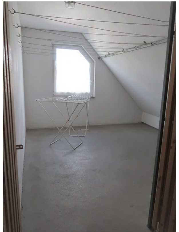
Trockenraum im Spitzboden
