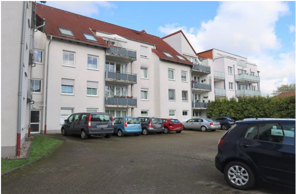
Teilansicht rückseitige Fassadenfläche
