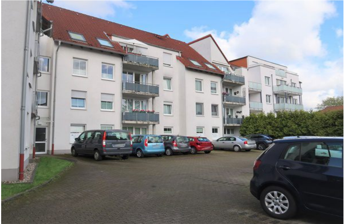
Teilansicht rückseitige Fassadenfläche
