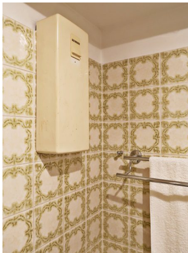
Elektrisch betriebener Durchlauferhitzer
