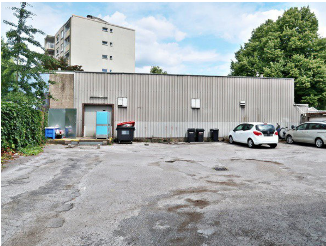
Hoffläche Wittener Straße 201 mit Seitenansicht des Gebäudes Lindengraben 14 und Toranlage zur Anlieferung
