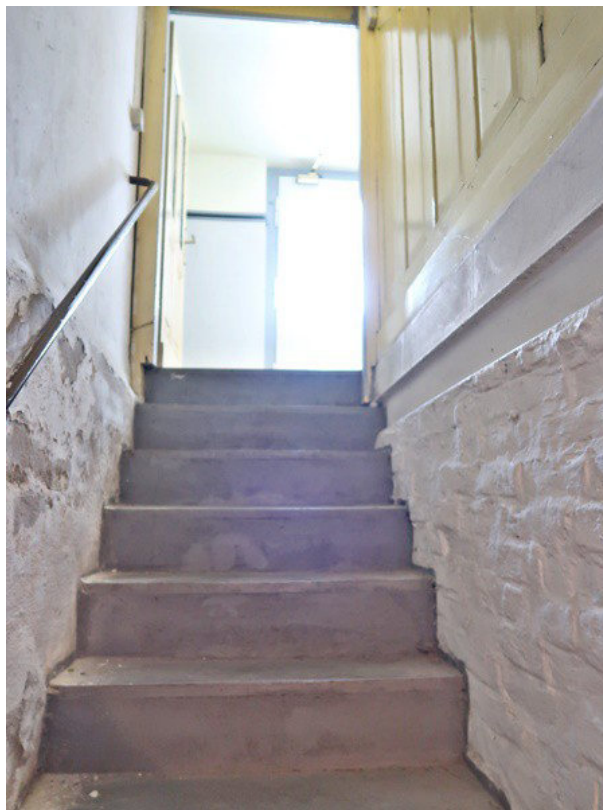
Treppe zum Kellergeschoss
