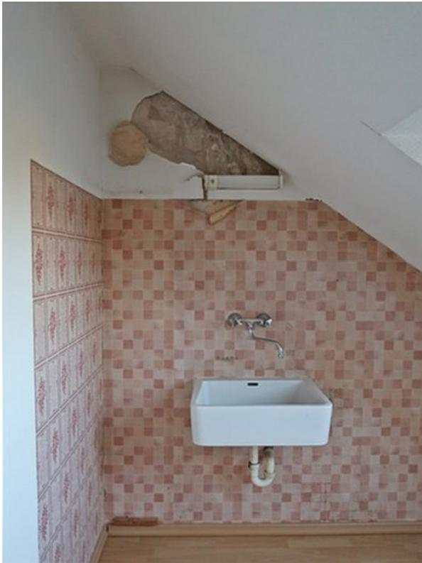
Teilansicht Teilfläche Bodenraum mit Feuchteschaden, ohne messbare Feuchtigkeit
