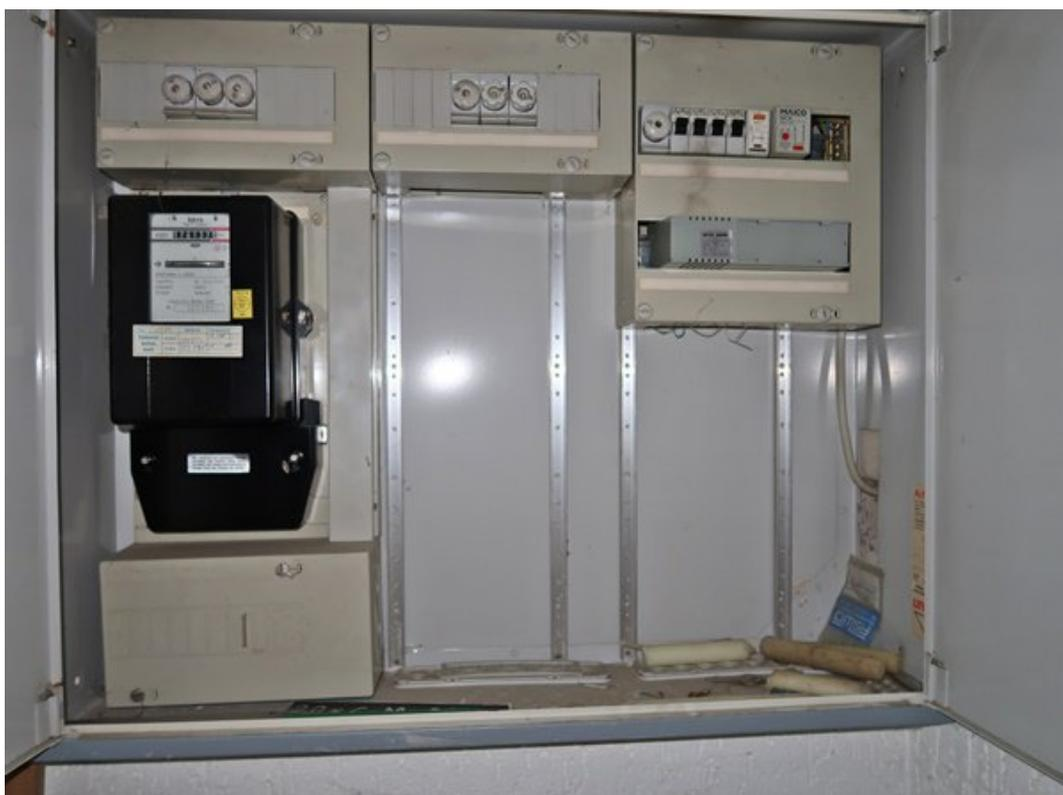
Zählerschrank mit Vorsicherungen und Elektrounterverteilung
