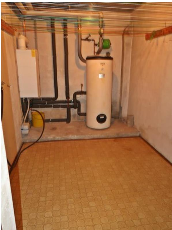
Heizungsraum mit Gasheiztherme und Warmwasser-Standspeicher
