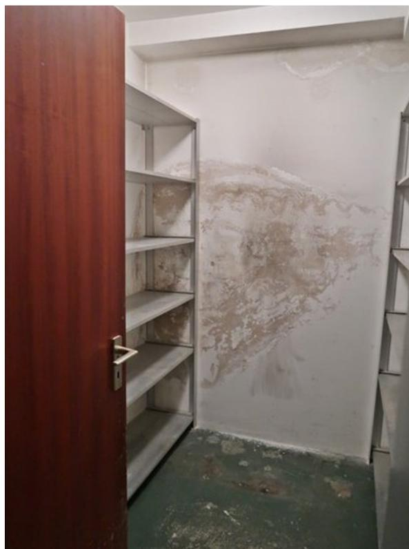
Lagerraum mit erheblichem Feuchteschaden an der Wandfläche
