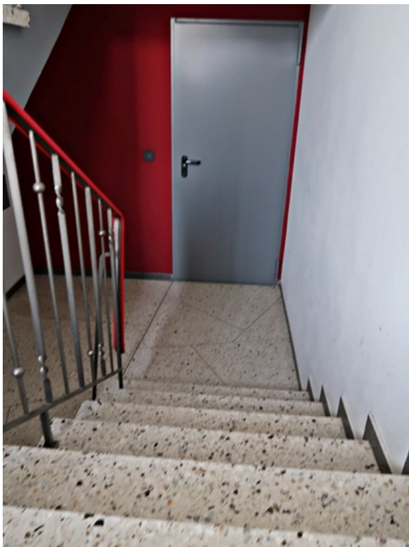
Treppe zum Kellergeschoss
