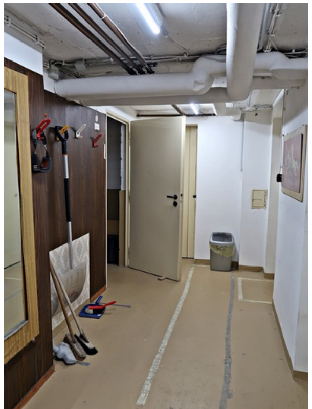
Kellergeschoss: Flur mit Tür zum Treppenhaus
