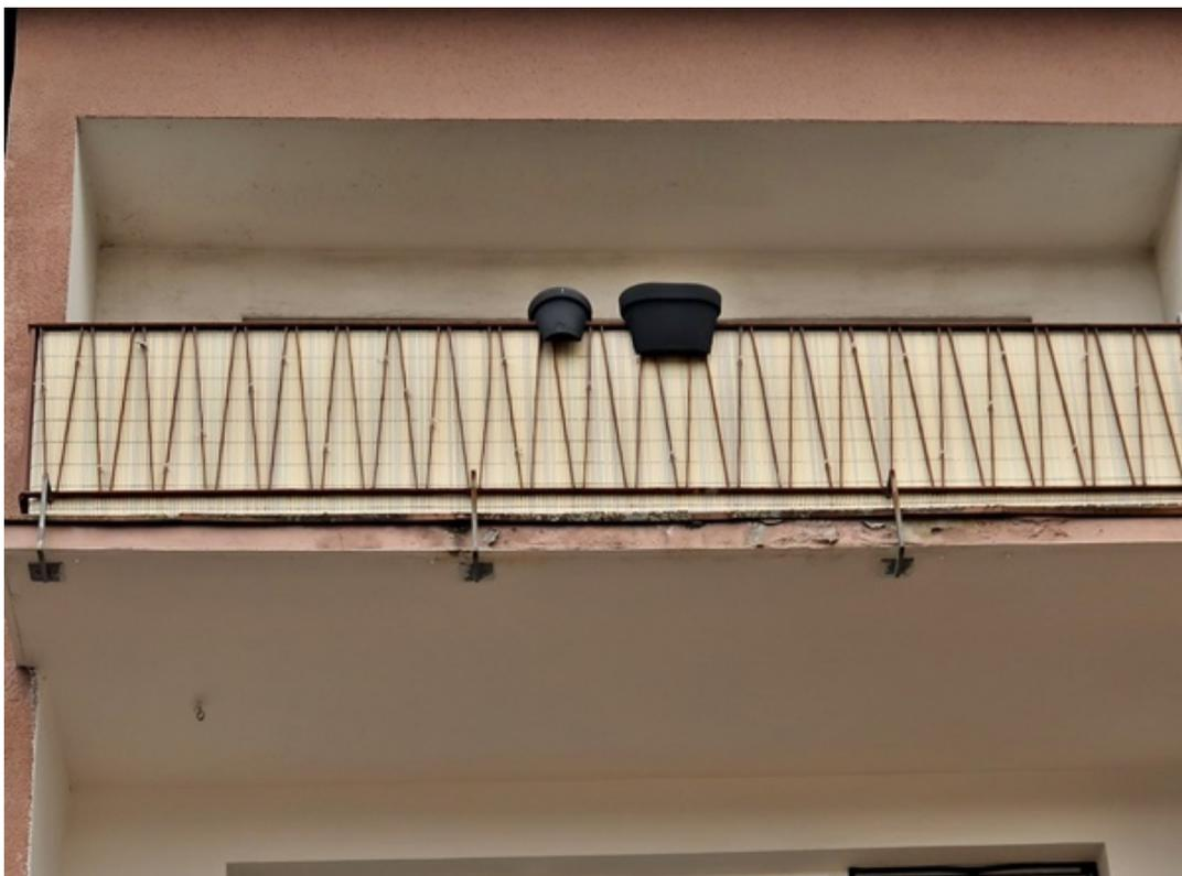
Risschäden und Abplatzungen Vorderkante Bodenplatte Balkon
