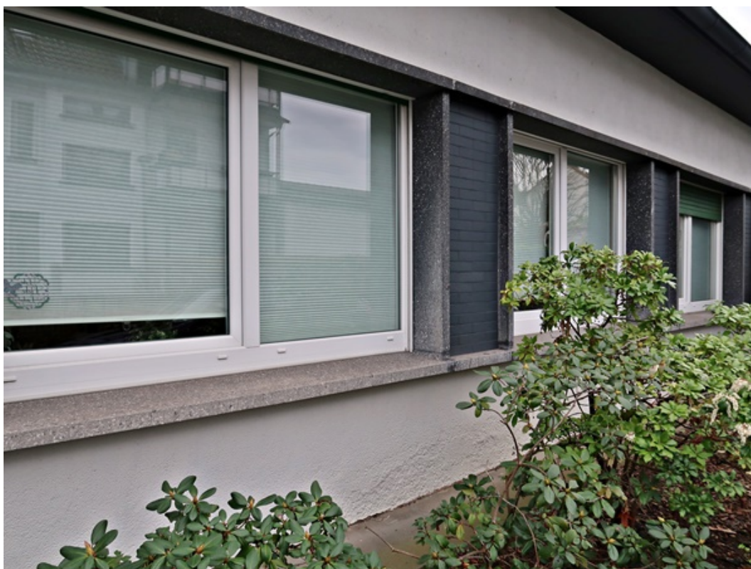
Teilansicht Fassadenfläche Räume Gaststätte
