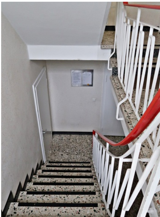
Treppe zum Kellergeschoss
