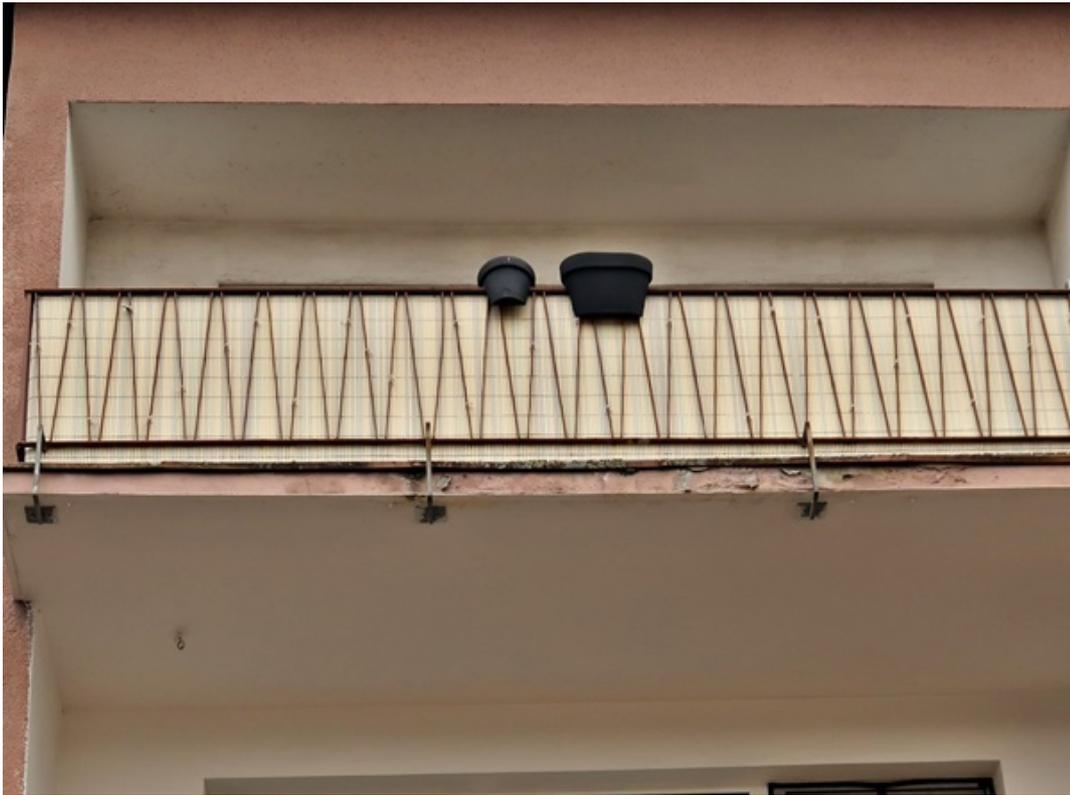
Risschäden und Abplatzungen Vorderkante Bodenplatte Balkon
