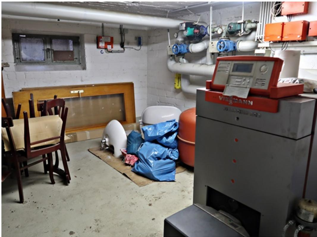
Heizungsraum mit Ölheizkessel
