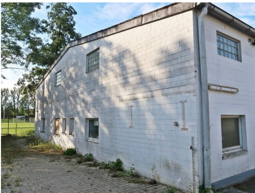
Ansicht von der Giebelseite
