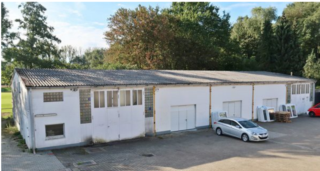
Lagerhalle: Ansicht von der Hoffläche
