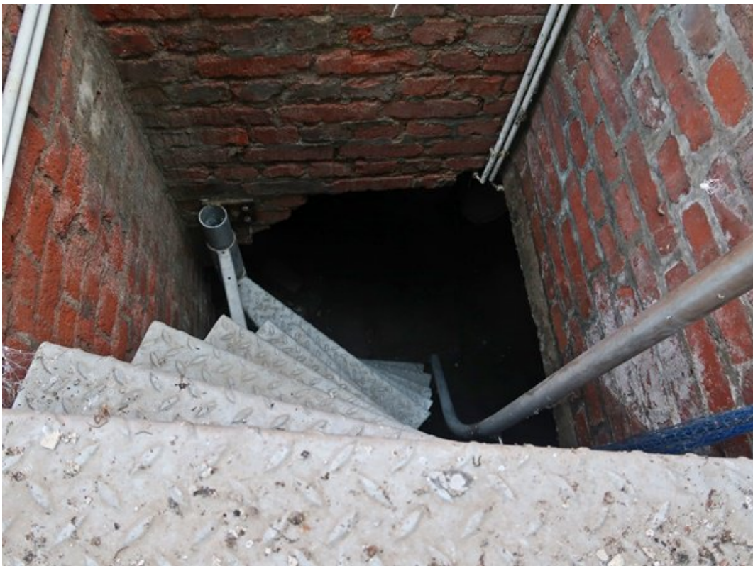
Zugang zum Keller mit Lage unter der Terrasse
