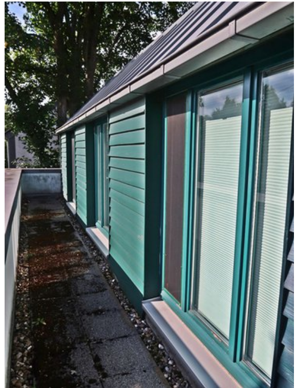
Teilansicht straßenseitige Fassadenfläche Dachgeschoss
