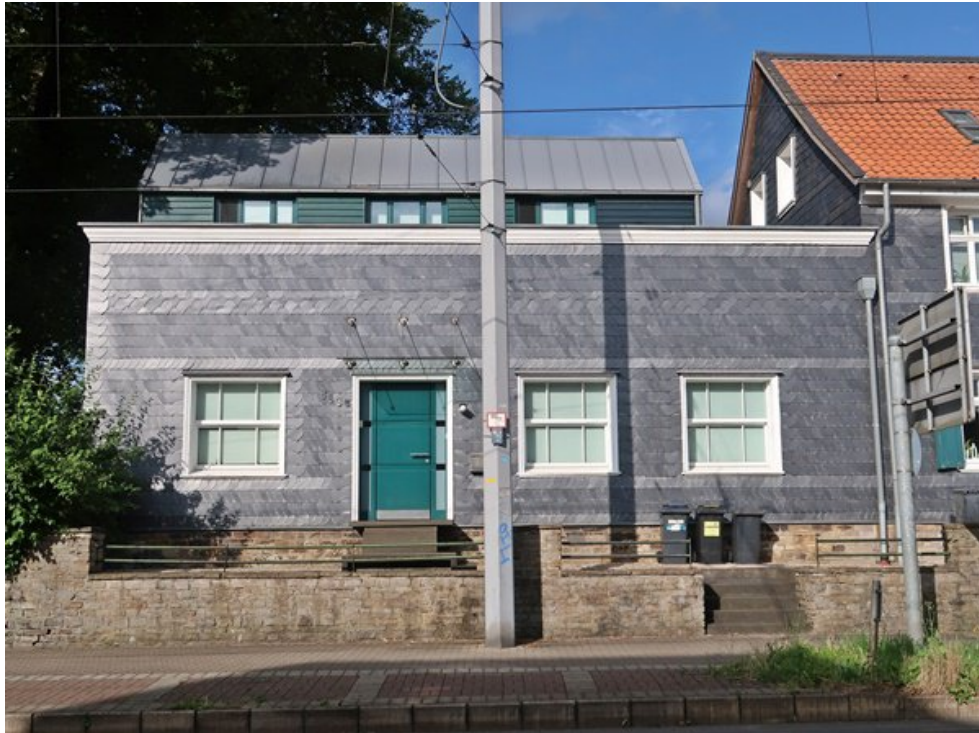
Ansicht von der Hattinger Straße
