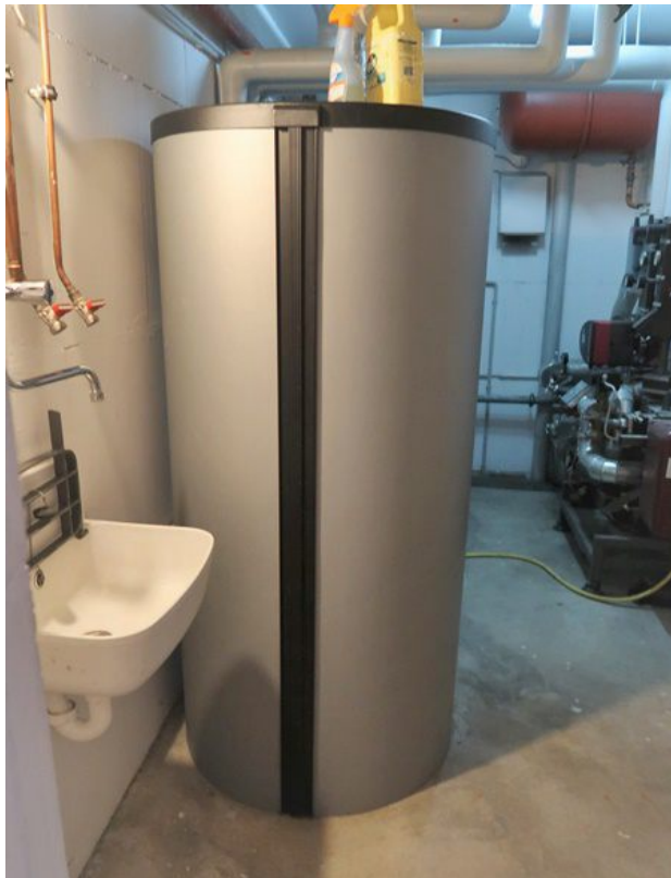
Hausanschlussraum mit Fernwärmeübergabestation und Warmwasser-Standspeicher
