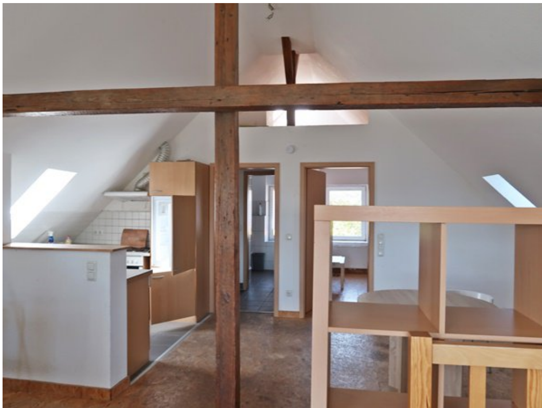
Dachgeschoss, wohnraumähnlich ausgebaut, Nutzung zu Wohnzecken nicht genehmigt
