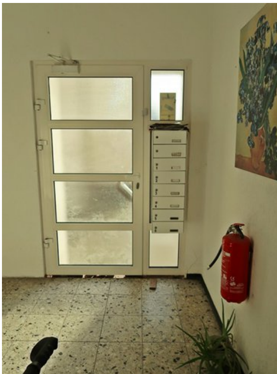
Treppenhaus mit Hauseingangstür
