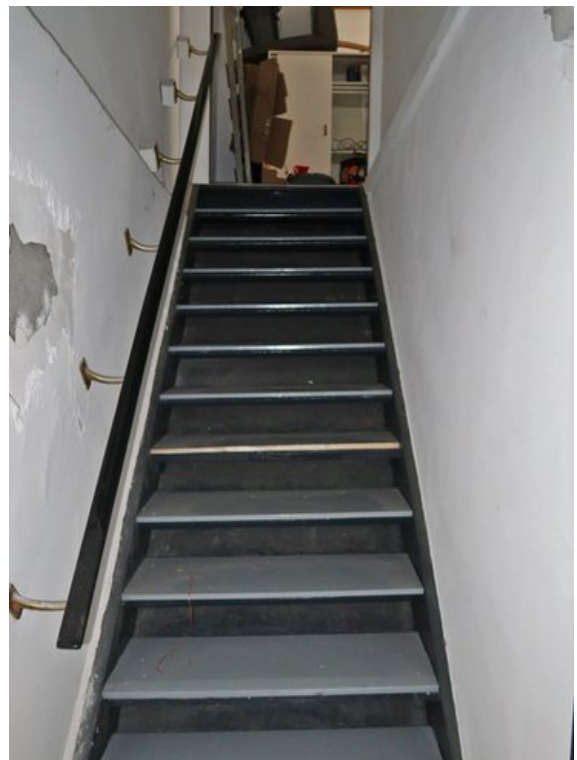
Treppe zum Kellergeschoss
