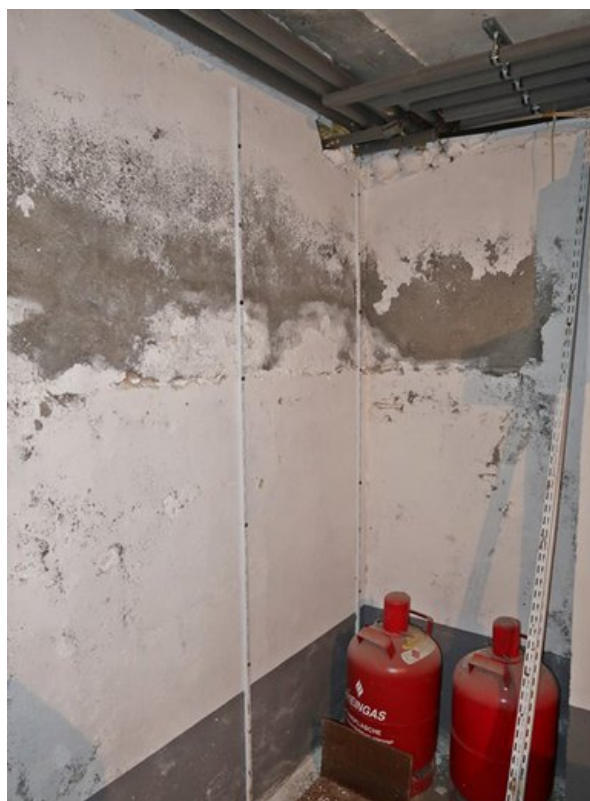
Feuchteschäden Wandfläche
