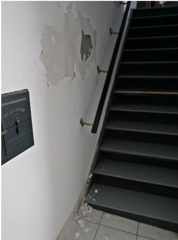
Feuchteschäden Wandfläche
