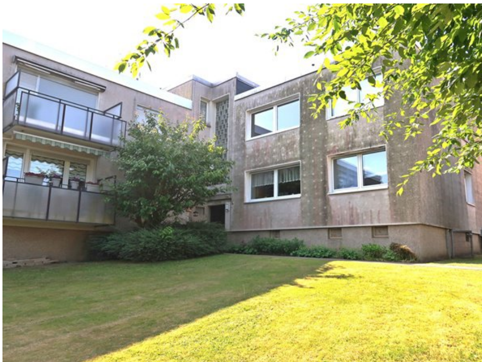
Ansicht von der Gartenseite mit Hauseingang
