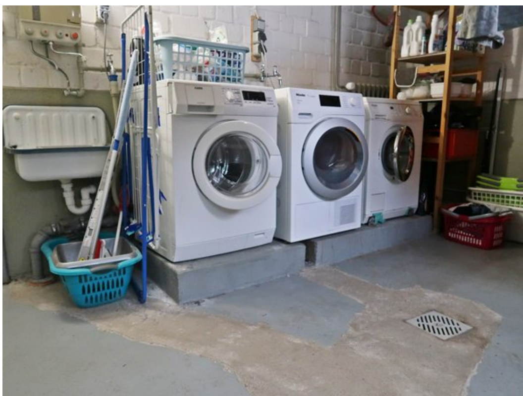
Wasch- und Trockenraum
