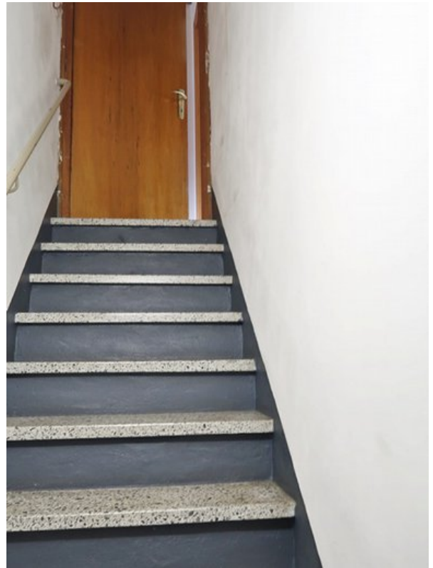
Treppe zum Kellergeschoss
