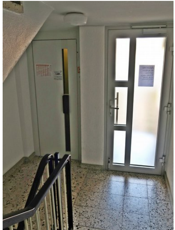
Treppenhaus mit Hauseingangstür, links daneben der Personenaufzug
