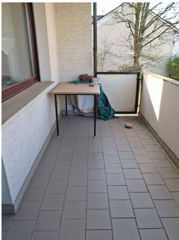
Loggia mit Zugang vom Wohnraum
