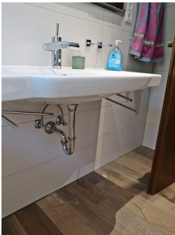
Feuchteanzeichen unter dem Waschbecken
