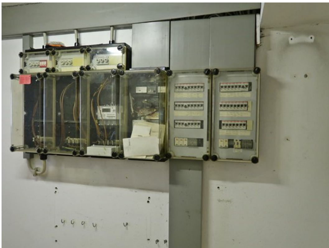
Elektrounterverteilung
