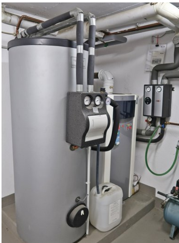
Ölheizkessel und Warmwasser-Standspeicher
