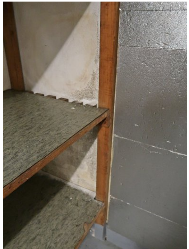
Feuchteschäden Wandfläche Lagerraum
